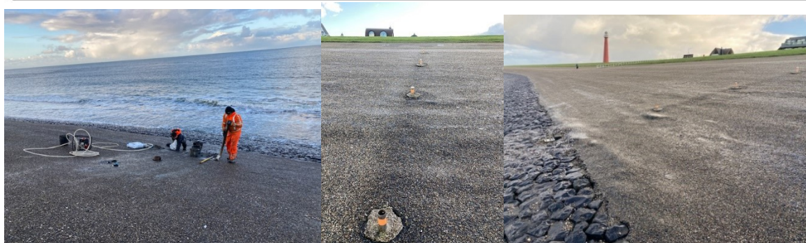
Figuur 2-9: plaatsen van de peilbuizen in de Helderse zeewering.
