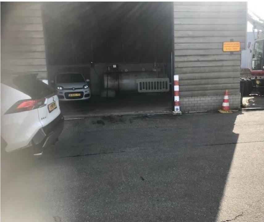
Foto 2. Toegang bulk tank locatie Mijdrecht
