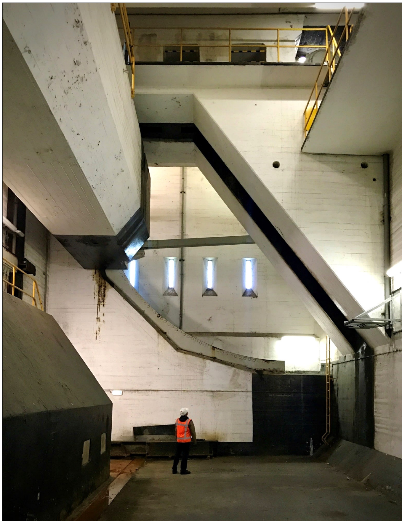
Figuur 1 - Basculekelder Verkeersbrug Dordrecht
