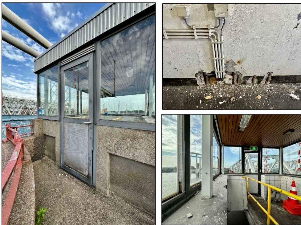
Figuur 17 - Impressie bouwkundige werkzaamheden
