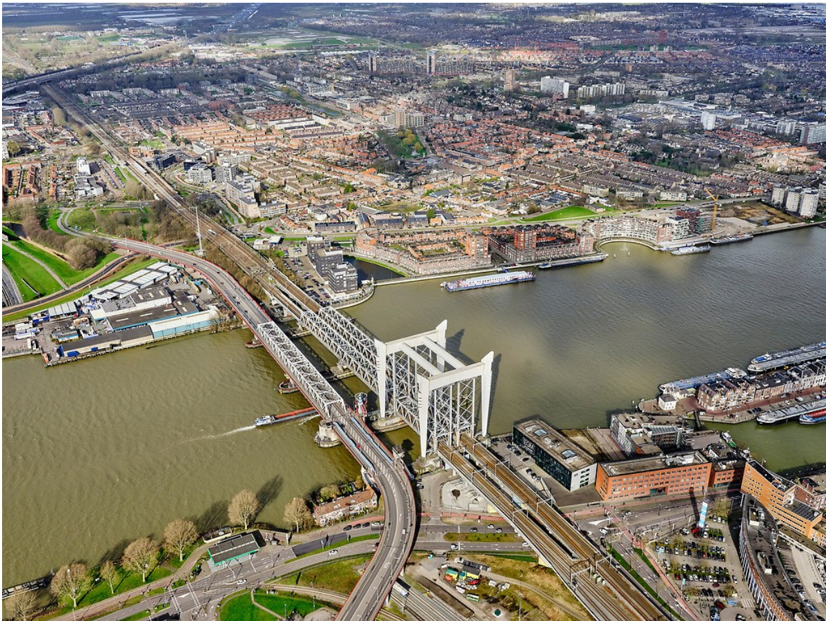
Figuur 2 - Bovenaanzicht Verkeersbrug Dordrecht
