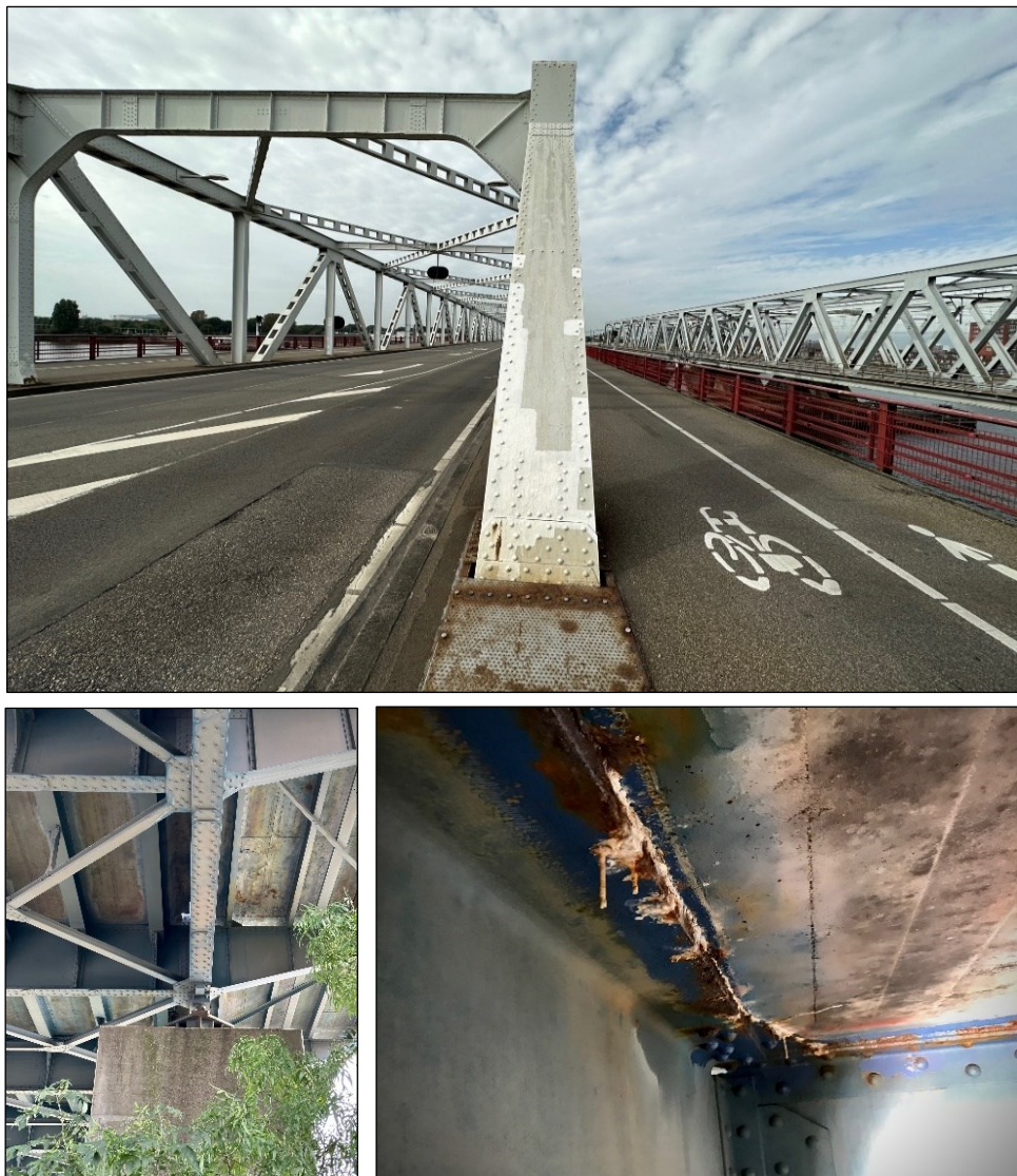
Figuur 13 - Impressie staalwerkzaamheden
