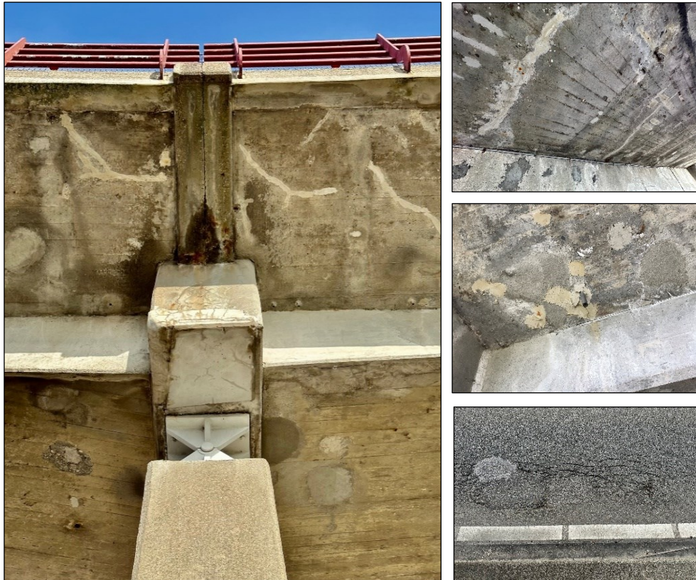
Figuur 10 - Impressie betonwerkzaamheden
