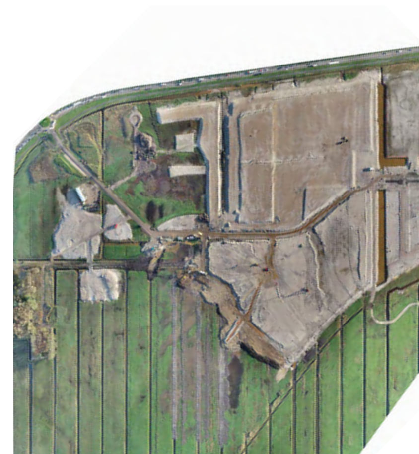
De grondverbetering van WG-III west in aanleg
