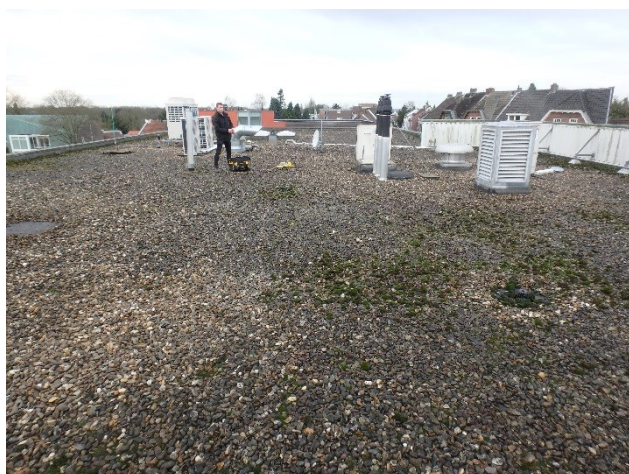
Foto 1 Overzicht grote hoge dak.
