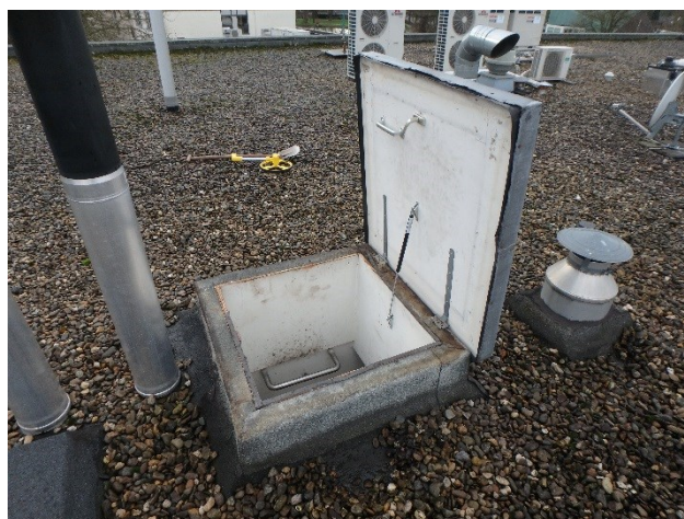
Foto 2 Daktoegang tot grote hoge dak.
