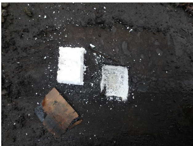
Foto 3 Insijding 2 op het grote hoge dakvlak.
