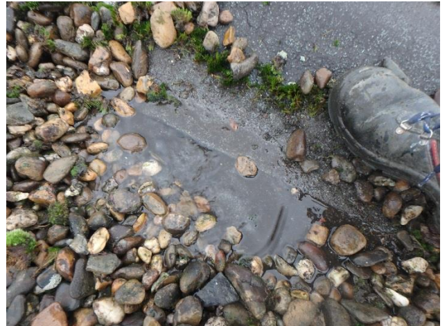
Foto 8 Waterblaas in opstand lichtkoepel.
