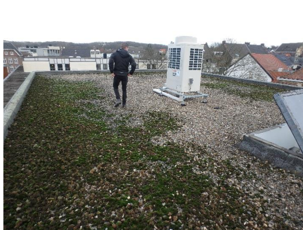
Foto 16 Kleine hoge dakvlak.
