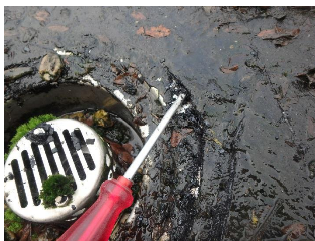
Foto 6 Onthechting plakstuk van hemelwaterafvoer.
