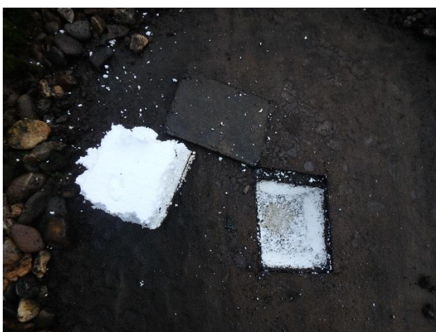
Foto 17 Insnijding kleine hoge dakvlak.
