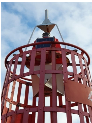
Afbeelding 14: Radarreflector gemonteerd in het dagmerk.
