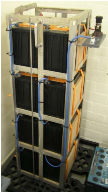
Afbeelding 19: Accu's met spanbanden in accurek vastgezet.
