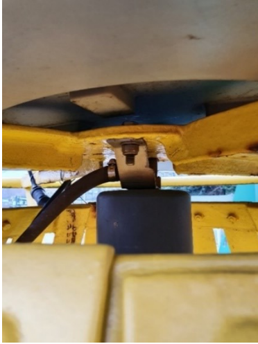
Afbeelding 20: Ontluhtingspot, gemonteerd aan de flens boven in het dagmerk.
