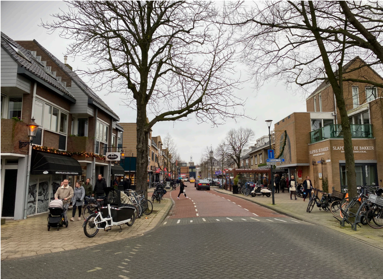
Winkelstraat Gerrit van Assendelftstraat richting Kerkplein
