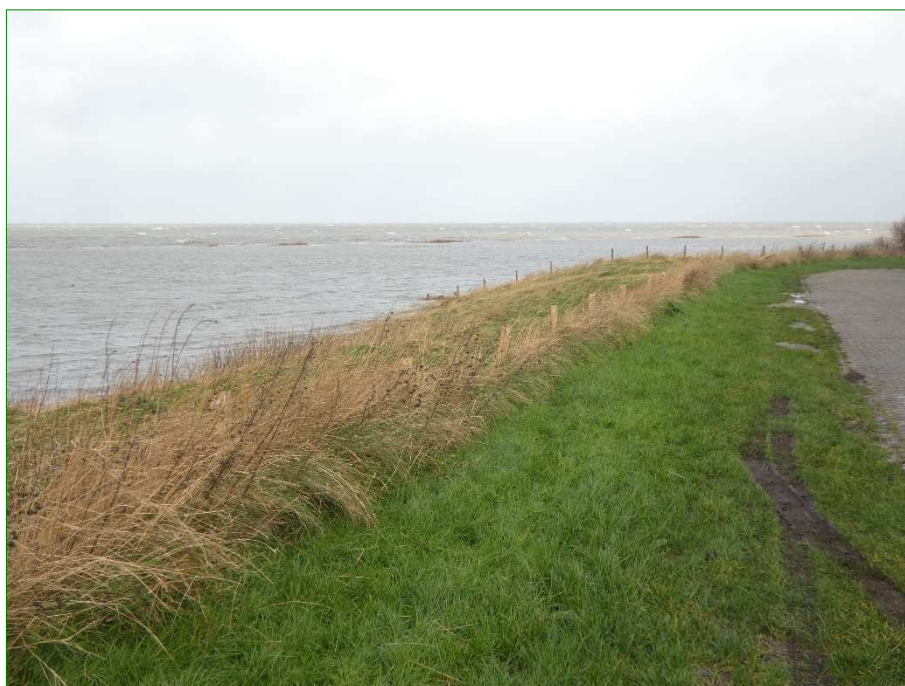
Aan de zuidrand van de kleiput is enige dekking aanwezig.
