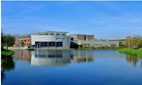
Hoofdingang aan De Aanloop
