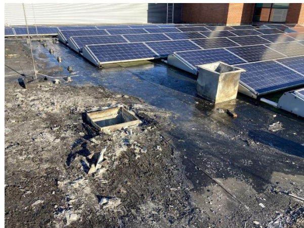
Dakuitlaat afzuiginstallatie
