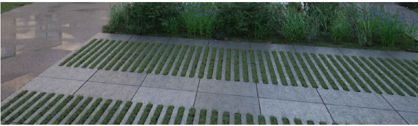
Profiel 1 schaal 1:50 Parkeren Middenberm Parkeren bestaande tegels 300x300 nieuwe verharding SoliDrain 125-75x62,5 bestaande tegels 300x300
