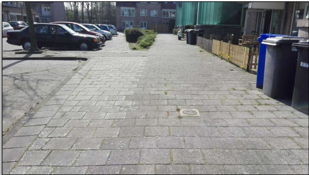
Foto 2.6 Aanpak: maken robuuste groene zone door verwijderen overtollige verharding en vervangen versleten plantsoenvakken.
