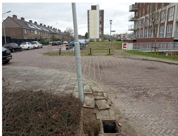
Kolkaansluiting in de Debora Bakelaan is van pvc
