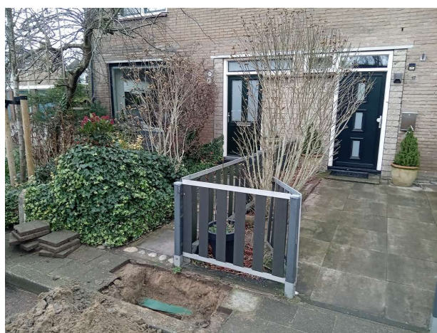
Huisaansluiting Heckemerstraat 17 is van pvc
