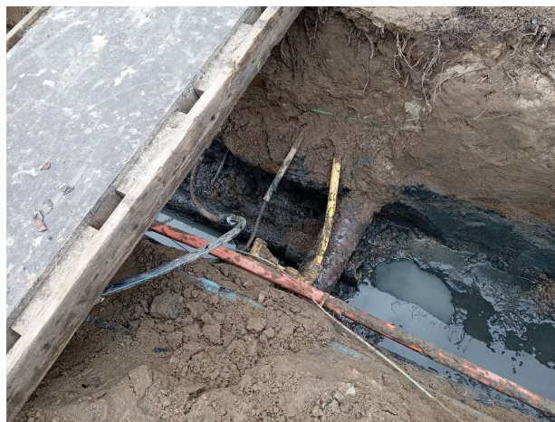
Huisaansluiting Willem van Velsenstraat 2 en 4 is van gres met asbesthoudende kit
