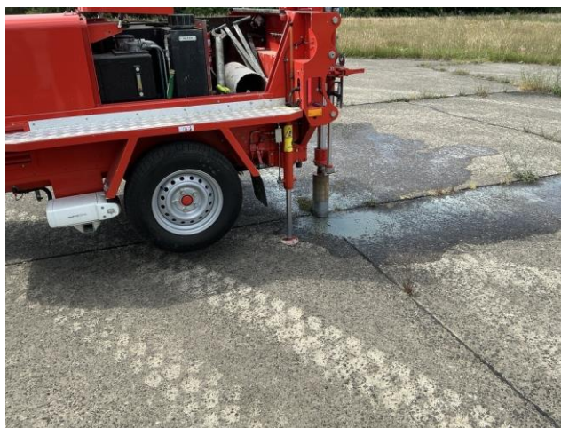
Destructief onderzoek kruisingen en lange naden met boorwagen aan betonplaten
