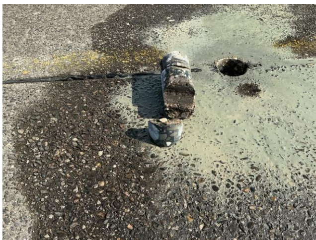
Aan de onderzijde boorkernen geen scheurinleiders aangetroffen
