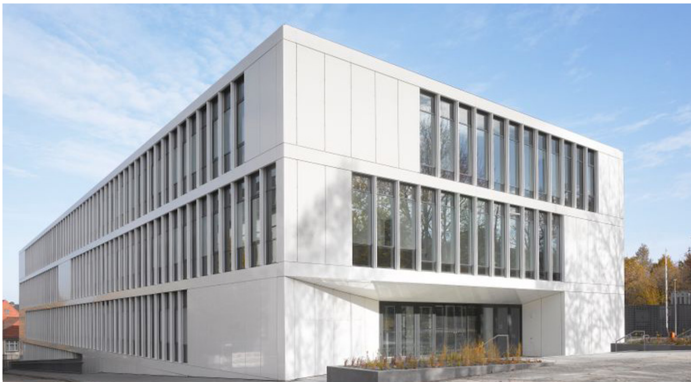
Referentie belevingswaarde - TU Dresden Hermann-Krone-Bau
