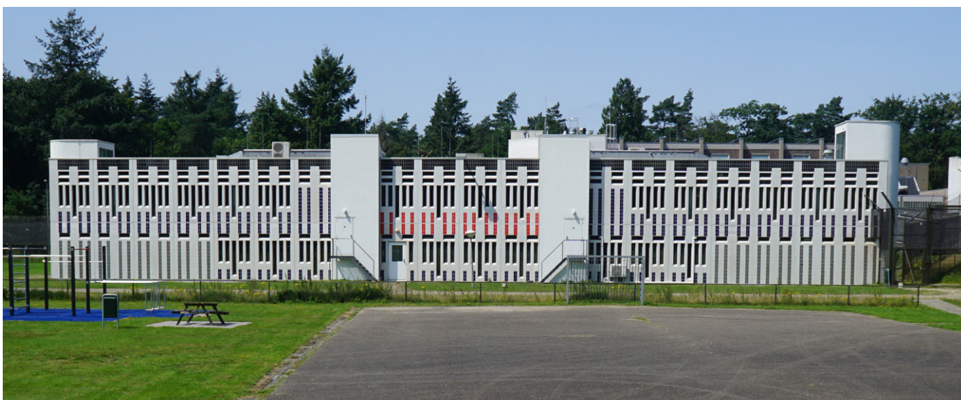
Bestaande bebouwing - uitbreiding ontworpen door L. Heijdenrijk
