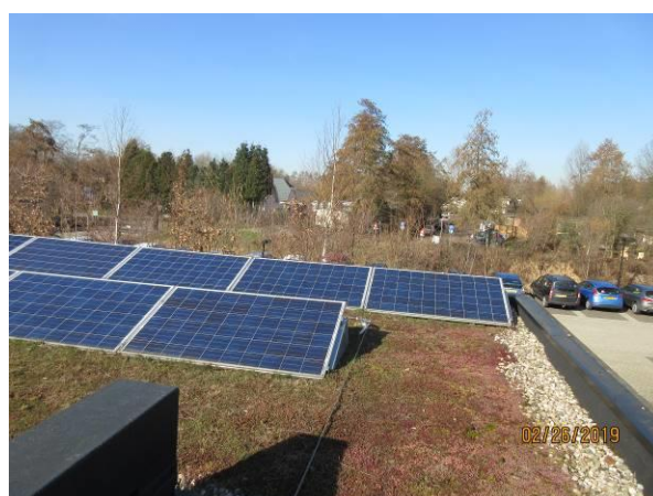
Zonnepanelen zijn geïnstalleerd op de houtskeletgebouwen met groene (sedum) daken.
