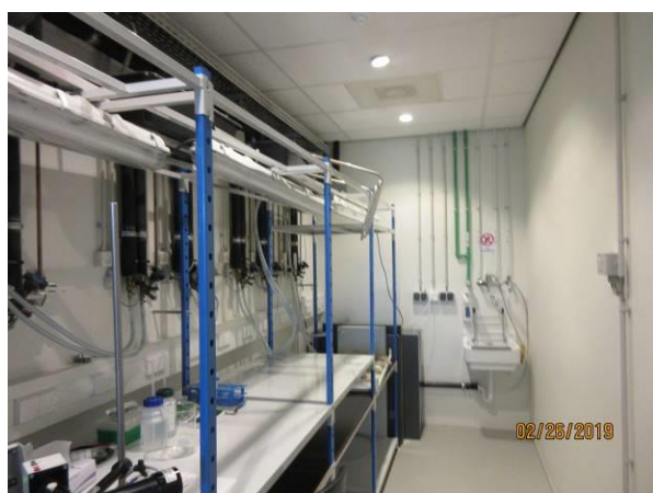
Gebouw 1: onderzoeksruimten in de binnenschil.
