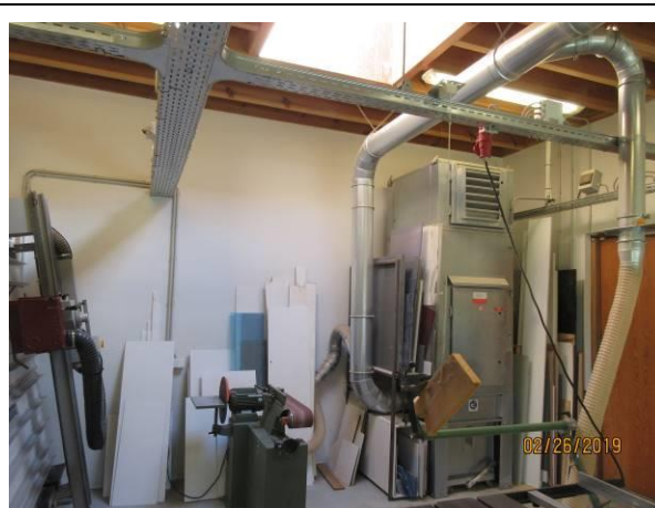
Gebouw 2: inkijk in de werkplaats met houtbewerking.
