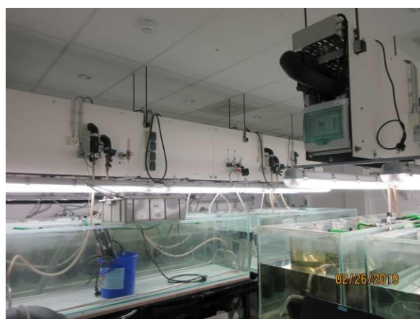
Gebouw 1: onderzoeksruimten in de binnenschil.
