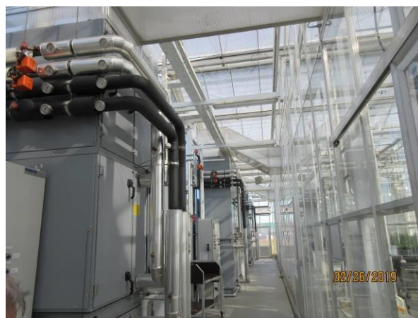
Gebouw 8: een inkijk in de corridor kassencomplex.
