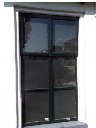
2: In de achtergevel aanwezig 6-ruits schuifvenster met verbrede middenroede.
