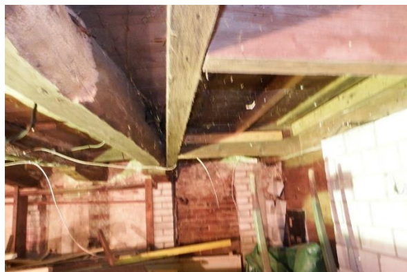
4: Verbouwing van de voorgevel (links) en het eerste balkvak, waarin een raveling is aangebracht (rechts).
