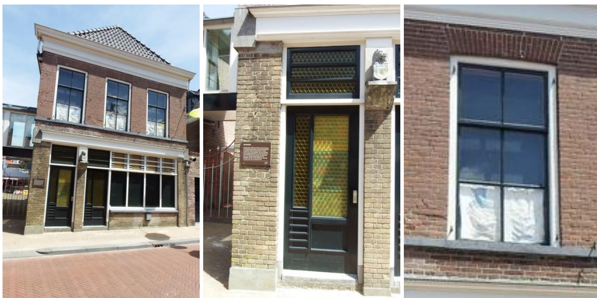
18: Voorgevel aan de Onnastraat. Links een overzicht, in het midden de entree met de expressieve horizontale en verticale belijning en rechts een 6-ruits venster met in de stijlen de duimen.
