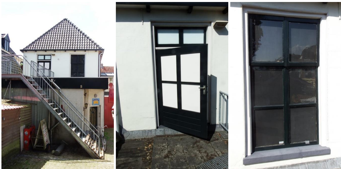
20: Achtergevel vanaf het binnenterrein. Links een overzicht, in het midden het tot deur met bovenlicht verbouwde venster en rechts het 6-ruits venster met verbrede middenroede.
