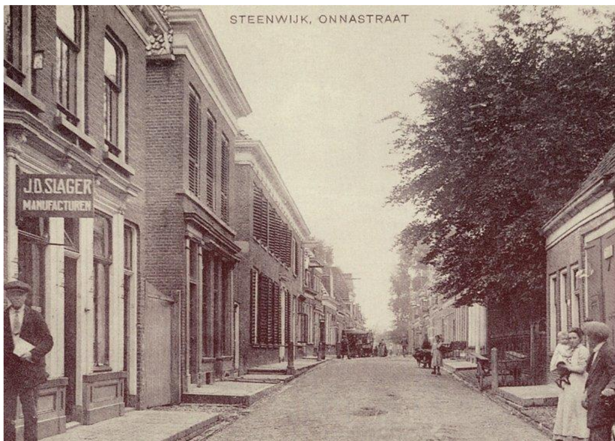
13: De Onnastraat gezien aar het zuiden waarop het tweede pand aan de linkerzijde het onderzochte huis is. Behalve de voorgevel op de eerste bouwlaag is er sinds die tijd weinig veranderd.
