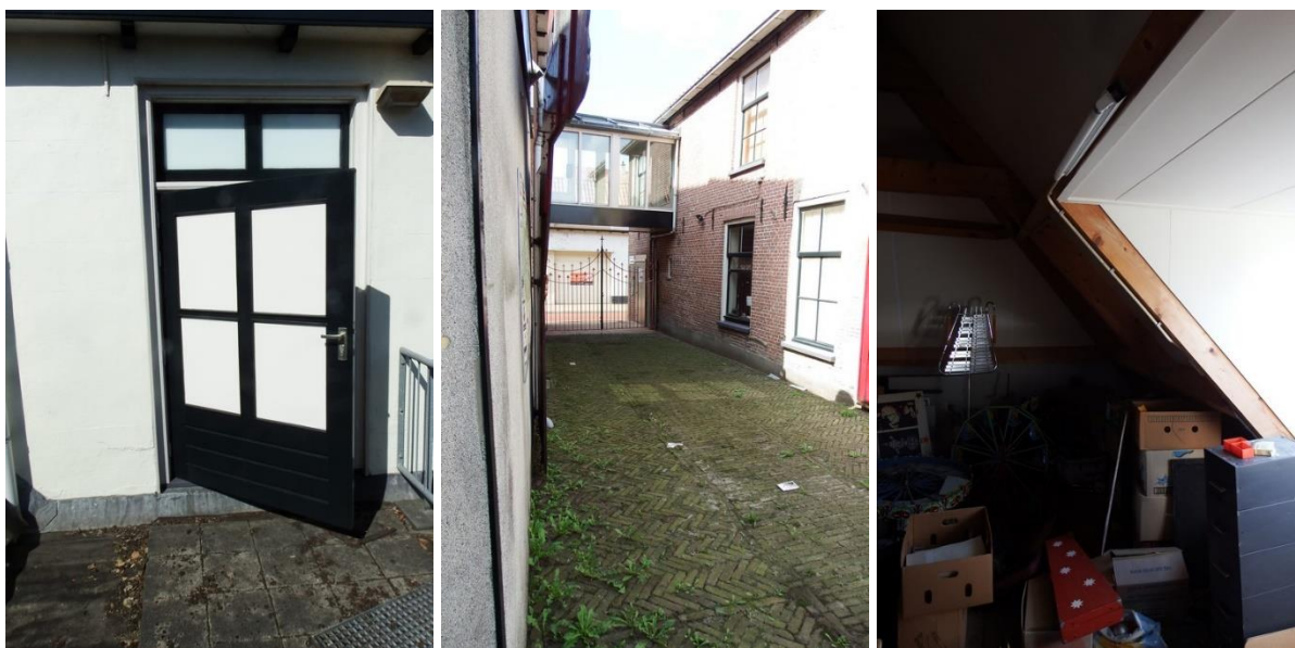
17: Links het tot vluchtdeur veranderd venster in de achtergevel, in het midden de luchtbrug tussen Onnastraat 7 en 3 en rechts de geheel vernieuwede zolderruimte.
