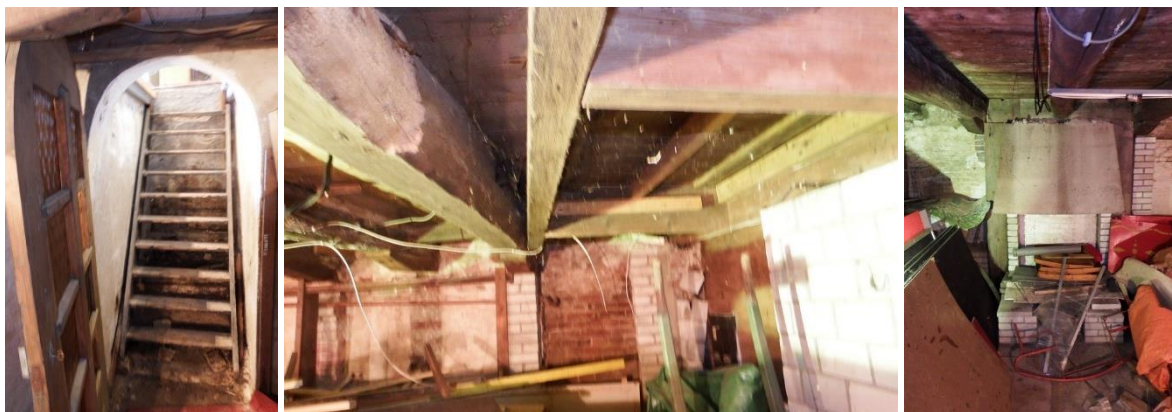
21: Kelder. Links de toegang met een rechte steektrap, in het midden de balken langs de voorgevel van gekantrecht hout en op de achtergrond beslagen rondhout en rechts de voorde fundering van de stookplaats (op de eerste bouwlaag) aangebrachte schouw.
