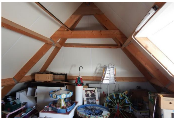
Figuur 25: Overzicht van de zolder naar de achtergevel toe met de moderne kapconstructie en geïsoleerde dakplaten.
