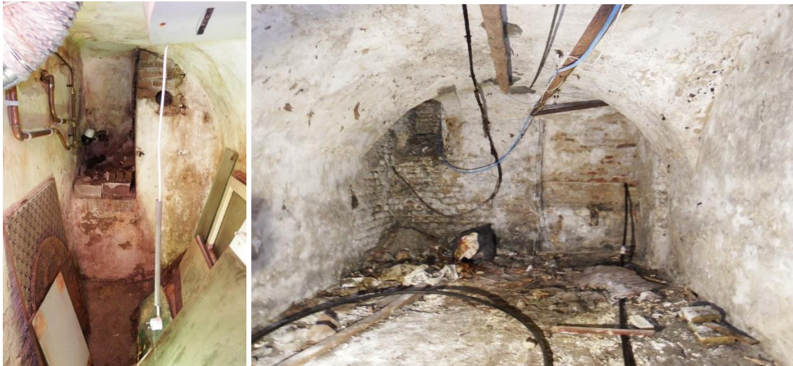
11: Overwelfde kelderruimte. Links de ruimte in Onnastraat 7 met de overwelfing, ondersteund door de zijmuur (links) gezien naar de voorgevel. Rechts de ruimte met de volledige overwelfing in Markt 64 gezien naar de voorgevel.
