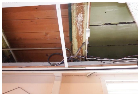
4: Balklaag op de eerste bouwlaag waarin het erstel van de vloer beschoot zichtbaar is.
