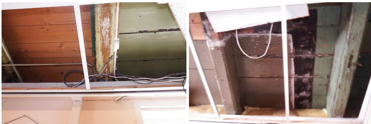
22: Details van de plafondbalklaag. Links het herstel van het vloerbeschot en rechts een aansluitende wand op het plafond die een smalle ruimte aangeeft, mogelijk een portaal of gang met trapopgang naar de tweede bouwlaag.
