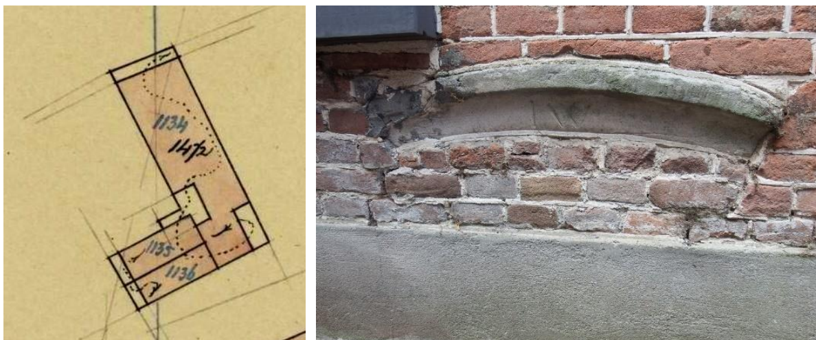
11: Verbouwing van het huis 1870. Links de uitsnede uit de kadastrale hulpkaart en rechts een zandstenen element dat de afscheiding vormt tussen oud metselwerk (onder) en nieuw metselwerk (boven).
