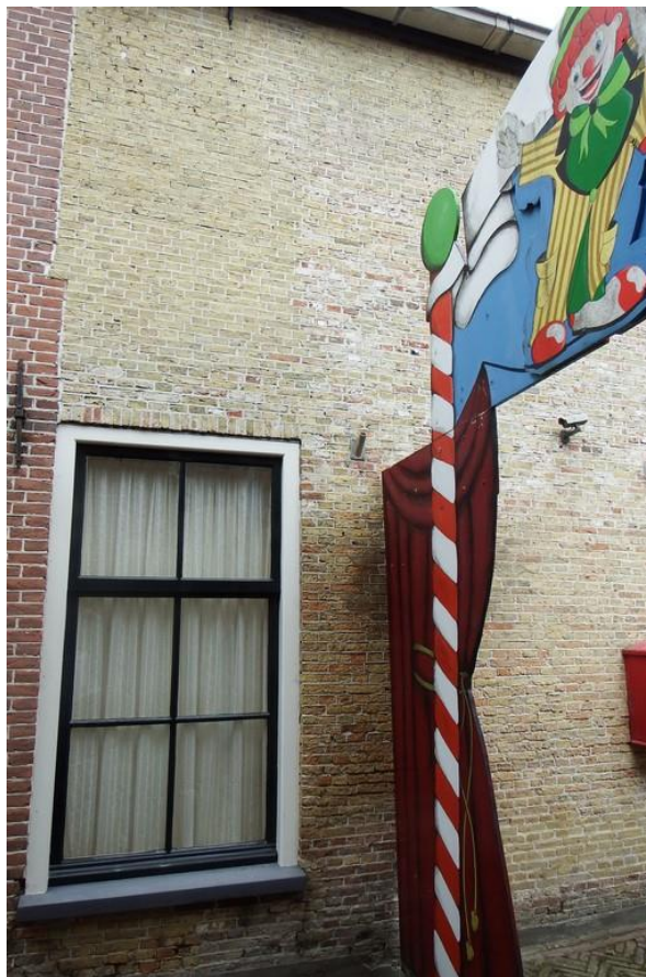
17: De verticale naad tussen de twee verschillende baksteensoorten in de rechter zijgevel. Boven het aanwezige venster is de dagkant van een verdwenen venster zichtbaar. Achter de poortvleugel is het herstelde metselwerk zichtbaar van de verwijderde vensters die op een afwijkende hoogte waren aangebracht.
