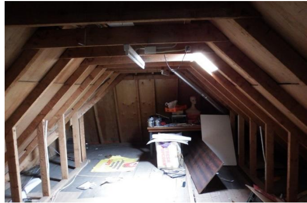
24: Zolderruimte gezien naar de achtergevel.
