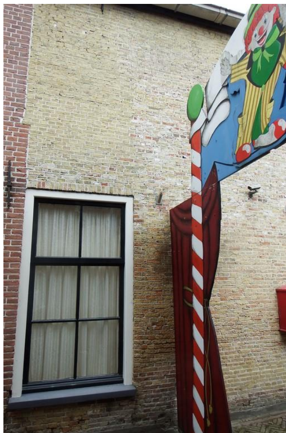
13: De verticale naad tussen de twee verschillende baksteensoorten in de rechter zijgevel. Boven het aanwezige venster is de dagkant van een verdwenen venster zichtbaar. Achter de poortvleugel is het herstelde metselwerk zichtbaar van de verwijderde vensters die op een afwijkende hoogte waren aangebracht.
