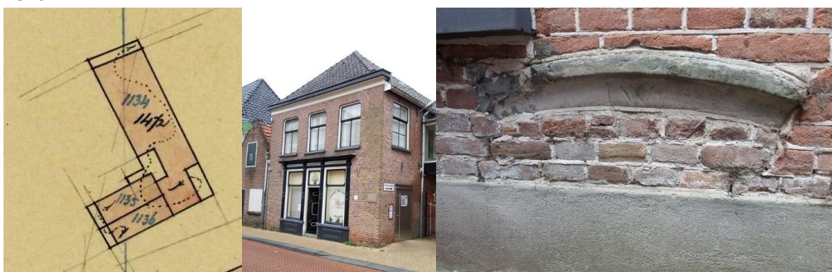
1: Verbouwing huis 1870. Links de uitsnede uit de kadastrale hulpkaart, in het midden de streng symmetrische voorgevel en rechts een zandstenen element dat de afscheiding vormt tussen oud metselwerk (onder) en nieuw metselwerk (boven). Bron foto links: Kadaster Archiefviewer, nr. HK_SWK01_E_143
