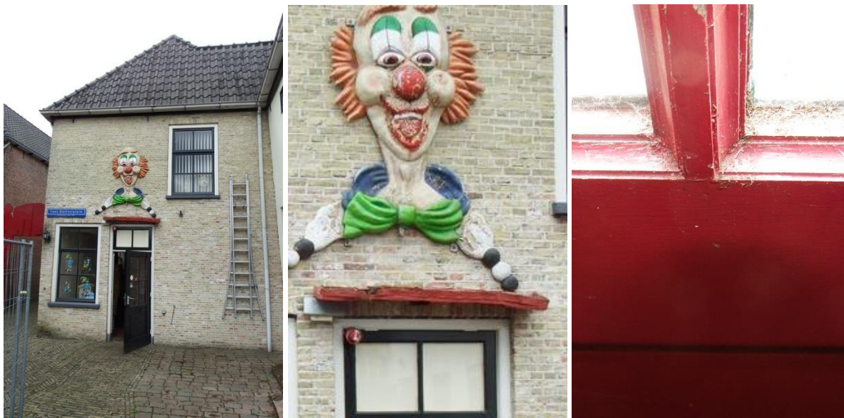
18: Achtergevel. Links een overzicht. In het midden een detail van deze gevel met een horizontale bouwnaad ter hoogte van de onderzijde van het venster op de tweede bouwlaag, die aangeeft dat deze gevel met twee partijen gele baksteen is opgebouwd als spouwmuur. Rechts een detail van de glasdeur die is uitgevoerd in meranti, een moderne houtsoort.
