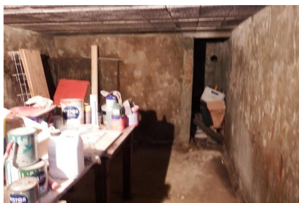
20: Kelderruimte naar de linker zijgevel. In het plafond is de combinatievloer met elementen in lichtbeton zichtbaar.
