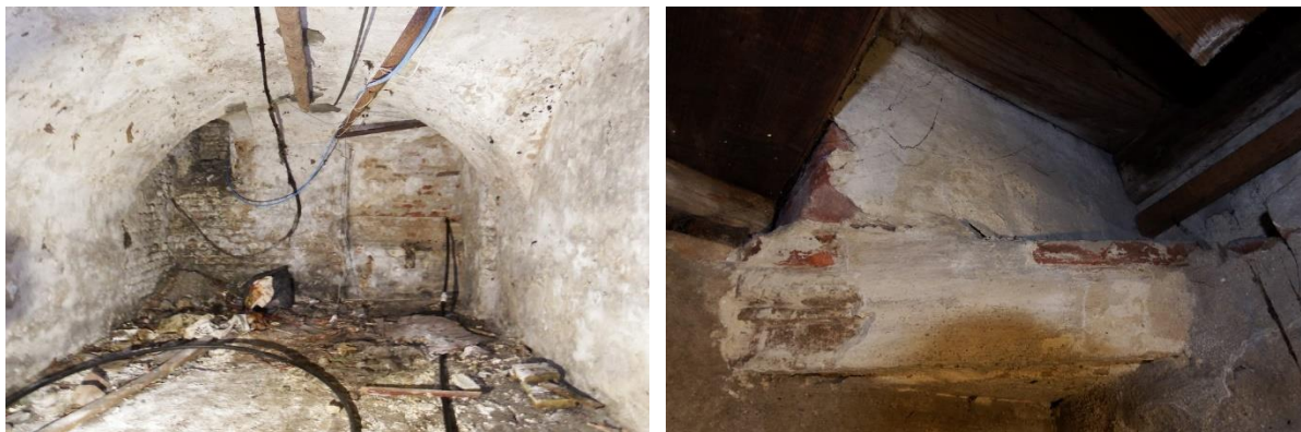
3: Interieur van de kelder aan de Markt. Links een overzicht gezien naar de voorgevel. In de voorwand links een kelderlicht en rechts de dichtgezette opening naar de straat. Rechts een zandstenen element dat voorzien is van een waterhol en gebruikt is als latei.
