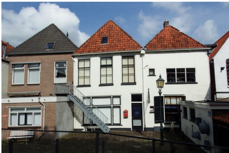
21: Wit gepleisterde achtergevel van Markt 64, waarin dunne schijnvoegen zijn getrokken.
