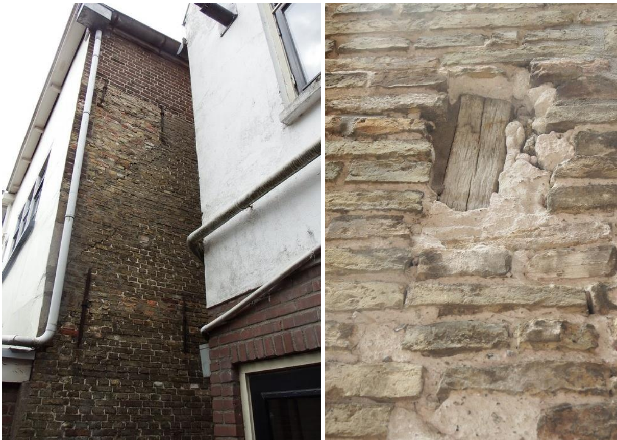
23: Linker zijgevel. Links het zichtbare gevelgedeelte bij de aansluiting met de achtergevel, waarin de ophoging en de blokvertanding op de hoek zichtbaar zijn. Rechts een restant van de houtconstructie in dit casco.
