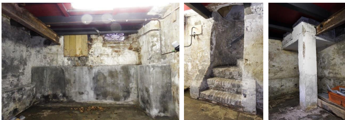
30: Interieur van de kelder aan de achterzijde. Links een overzicht gezien naar de achtergevel. In het rechter kelderlicht is het secundair verwerkte deurrooster zichtbaar. In het midden de gemetselde spiltrap en rechts een gemetselde kolom, waarop een betonnen plateau ten behoeve van de oplegging van de ijzeren onderslag.
