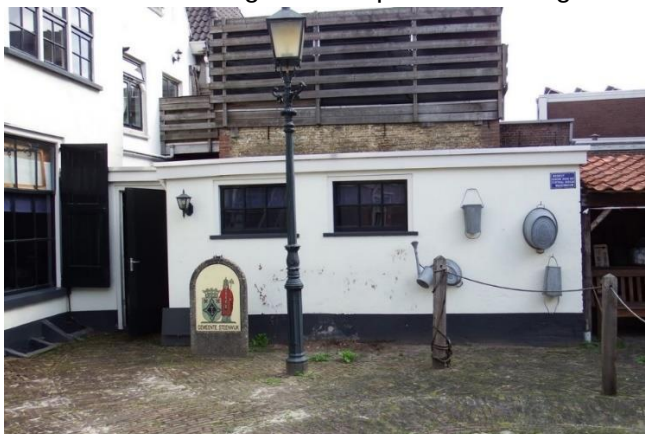
24: Rechter zijgevel van bouwdeel C met wit geschilderd metselwerk.
