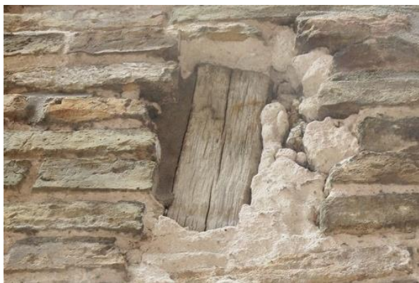
2: Aanwezige restanten van een houtskelet in de zijgevel van Markt 66. Links de verbinding van ankerbalk met de muurstijl in waarschijnlijk 18de-eeuws metselwerk en rechts in vroeg 20ste-eeuws metselwerk.
