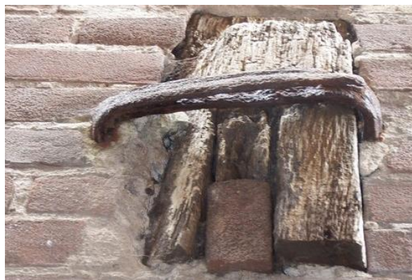
2: Aanwezige restanten van een houtskelet in de zijgevel van Markt 66. Links de verbinding van ankerbalk met de muurstijl in waarschijnlijk 18de-eeuws metselwerk en rechts in vroeg 20ste-eeuws metselwerk.
