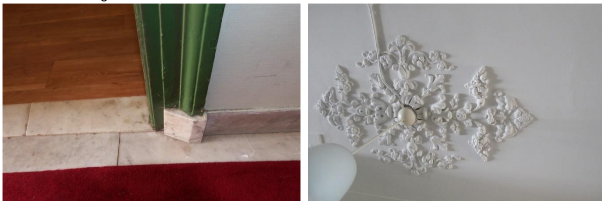
26: Interieur van de gang. Links de marmeren vloertegels met plint en neuten. Rechts het middenrozet op de grens van het brede het smalle ganggedeelte.
