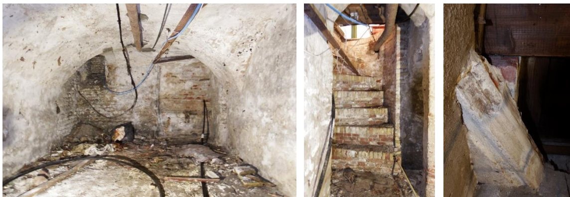
25: Interieur van de kelder aan de Markt. Links een overzicht gezien naar de voorgevel. In de voorwand links een kelderlicht en rechts de dichtgezette opening naar de straat. In het midden de in gele en rode bakstenen gemetselde spiltrap en echts een zandstenen element dat voorzien is van een waterhol en gebruikt is als latei.
