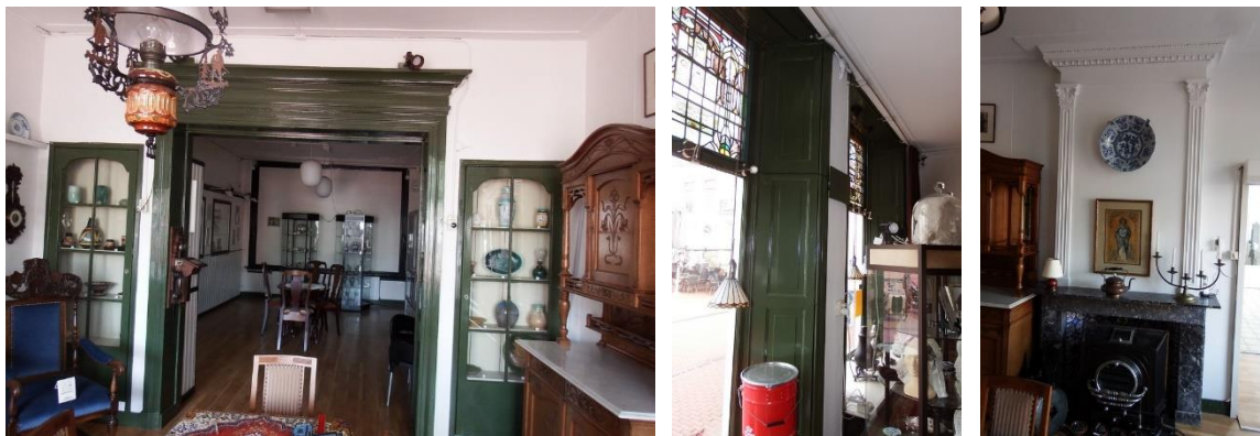
27: Interieur van de voorkamer aan de Markt. Links een overzicht gezien naar de achtergevel met de doorgang, waarin schuifdeuren aanwezig waren en geflankeerd door kasten. In het midden de voorzet wand tegen de voorgevel met binnenluiken. Rechts de schoorsteenmantel met natuurstenen vuurmond en betegelde achterwand.
