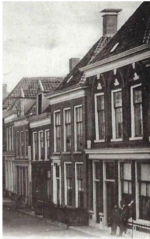
18: Voorgevel; links in 2021 en rechts rond 1900. Op de rechter foto zijn op beide bouwlagen vensters met meerruits schuiframen zichtbaar.
