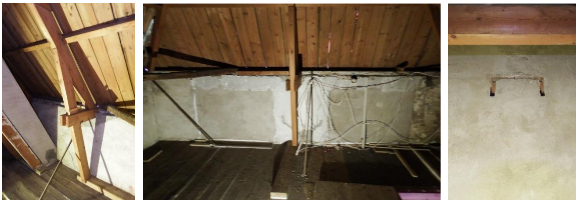
32: Interieur van de zolder achter 66. Links een linkerwand spantbeen op kreupele stijl en blokkeels. In het midden de blokkers achterwand met de dichtgezette openingen en rechts de voorwand met de ventilatiesleuven.
