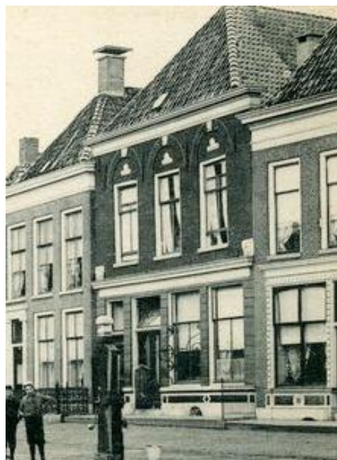
4: Foto: rond 1900 met geheel rechts het onderzochte huis. De eerste bouwlaag is voorzien van twee vensters en twee deuropeningen. Bron foto links: Beeldbank gemeente Steenwijk, nr. 226-0063
