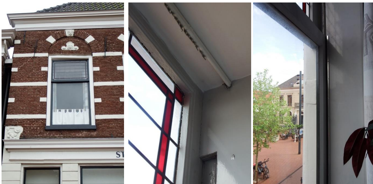
14: Schuifvenster in de voorgevel. Links een overzicht; in de bovendorpel is de afruk van een pengat zichtbaar. In het midden het bovenlicht met duivejager-profilering. Rechts de wisseldorpel met in de stijl de afdruk van de oorspronkelijke tussendorpel.
