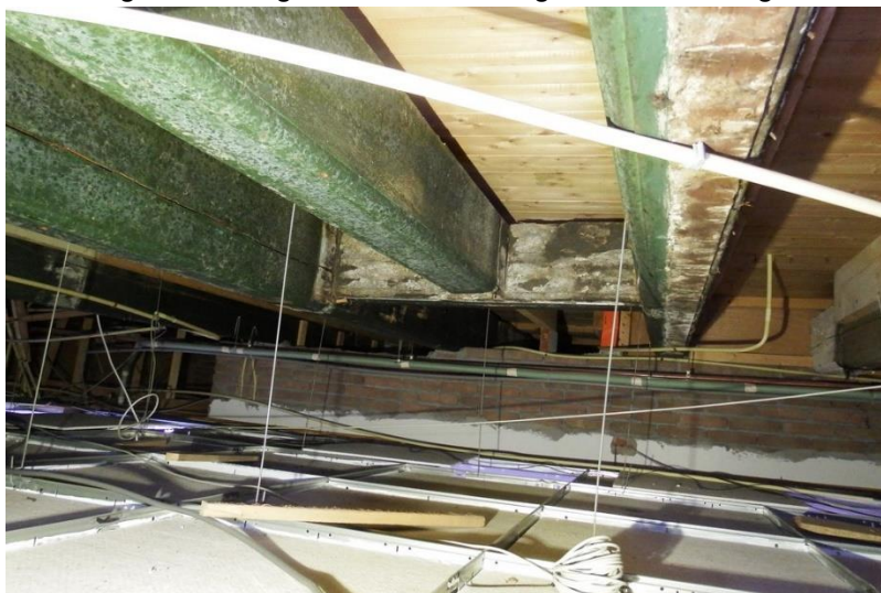
27: De midden in de balklaag aanwezige rameelbalk tussen twee smalle balkvakken.
