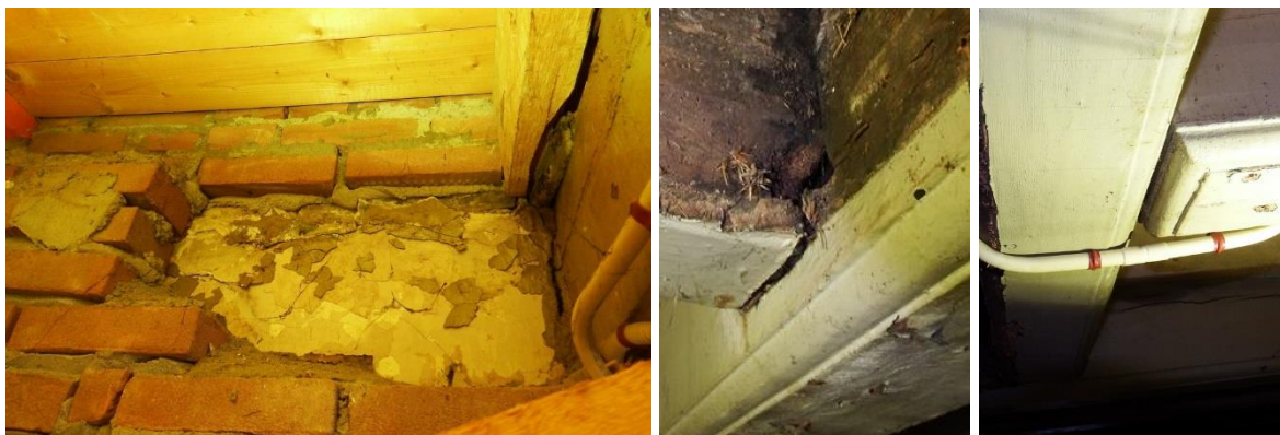
26: Op de linker foto de gepleisterde zijmuur met een versnijding, waartegen en op modern metselwerk in halfsteens verband is aangebracht. In het midden de hoofdrameelbalk met duivejager, waarin de rameelbalk is opgelegd; de balken zijn aan deze zijde beroet. Rechts de rameelbalk met duivejager en de staartbalk met omlopende duivejager.
