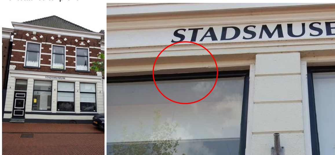
20: Voorgevel aan de Markt met links een overzicht en rechts de onderbreking van de profilering in de bovendorpel die wijst op een andere indeling van de twee vensteropeningen.
