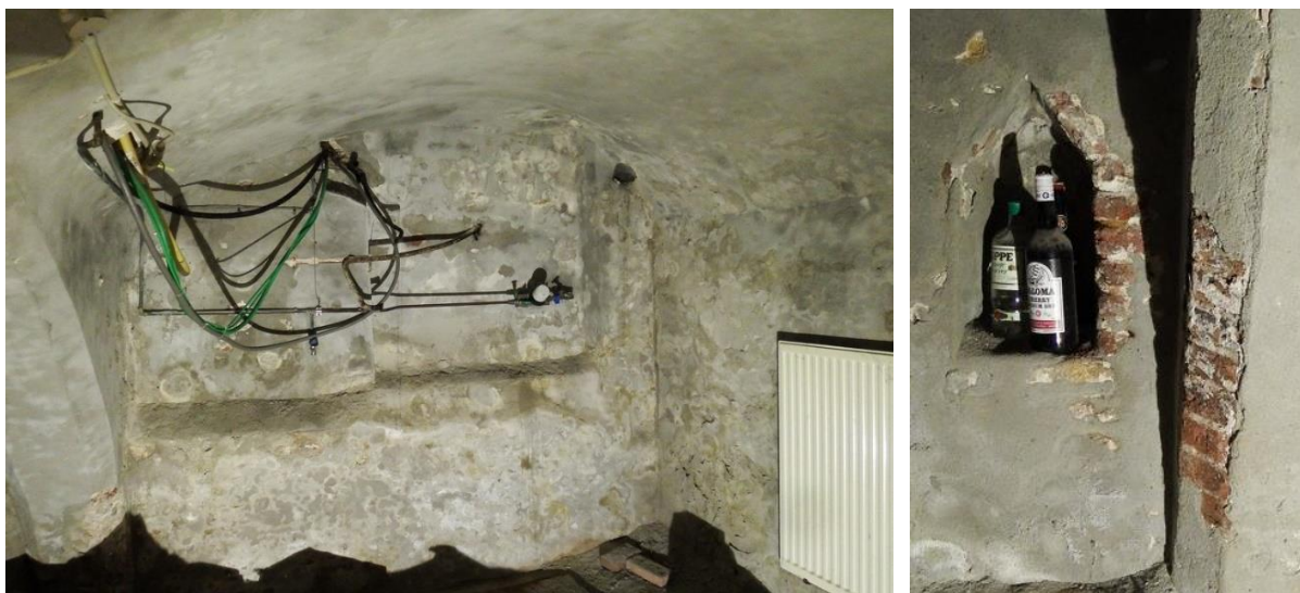
11: De linker kelder. Op de linker foto een aanzicht van de voorwand, waarin de dichtgezette opening aanwezig is. Op de prent (1744) het kelderluik op de straat zichtbaar. Rechts een kaarsnis in de achterwand van deze kelderruimte.
