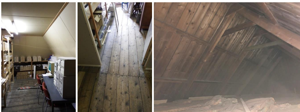
29: Links de geheel afgewerkte zolderruimte, in het midden de naden van de vloerdelen die een radiaal patroon volgen en rechts de kapconstructie op de vliering.
