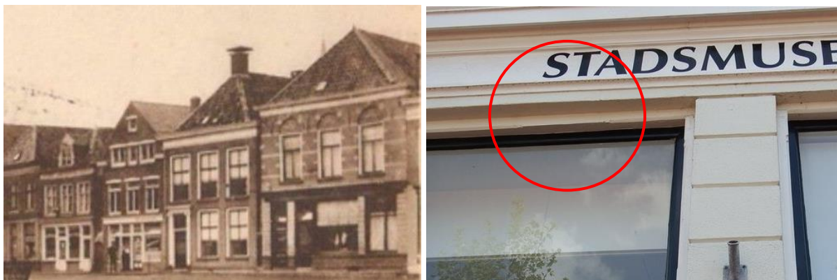
17: Winkelpui in de voorgevel. Links de situatie rond 1925 met in de voorgevel van het huis de winkelpui, waarvan de bovendorpel nog aanwezig is. Rechts de betreffende bovendorpel waarvan de versieringen ter plaatse van de aansluiting van de deurstijl zijn onderbroken; bij de aansluiting van de huidige stijlen loopt het dorpelprofiel door
