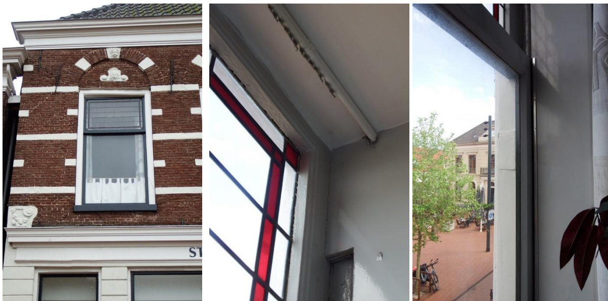
21: Schuifvenster in de voorgevel. Links een overzicht; in de bovendorpel is de afruk van een pengat zichtbaar. In het midden het bovenlicht met duivejager-profilering. Rechts de wisseldorpel met in de stijl de afdruk van de oorspronkelijke tussendorpel.
