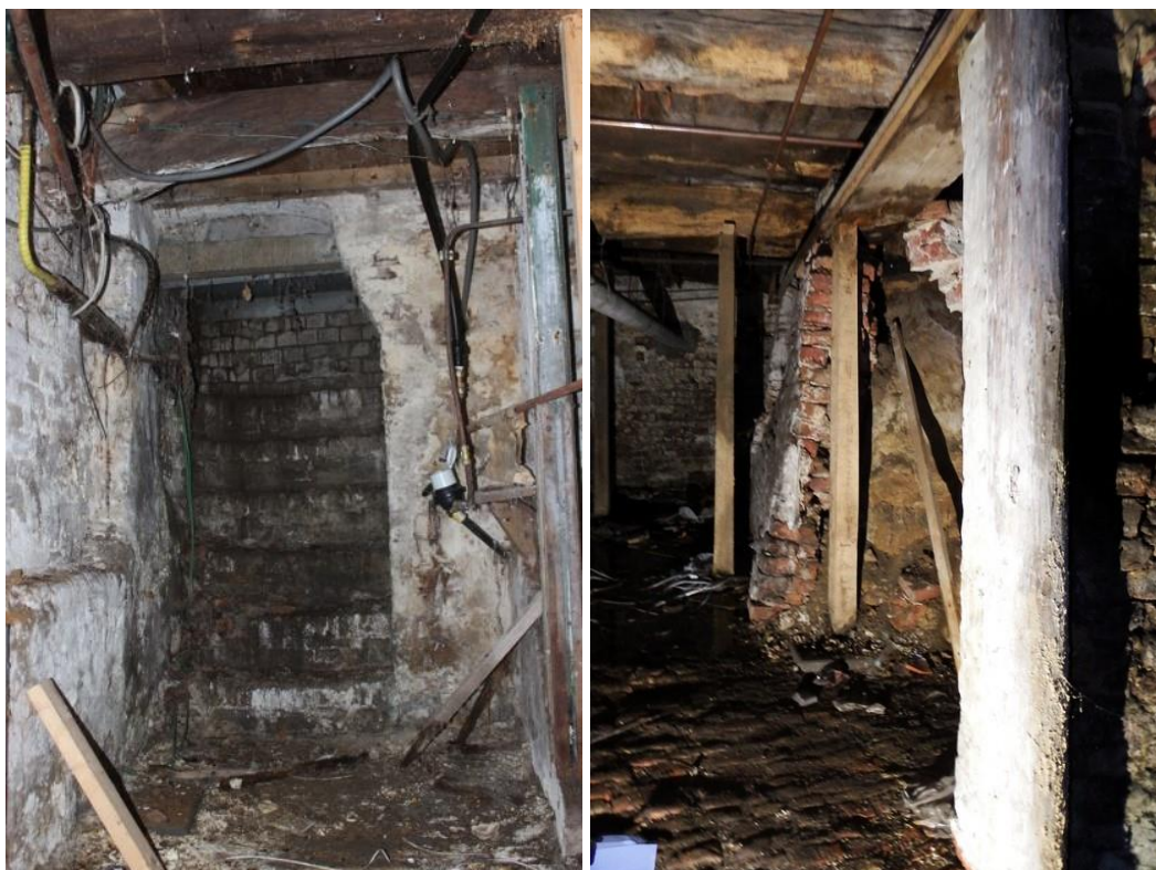
14: Wanden van de rechter kelder achter de voorgevel. Links de gemetselde buitentrap met aansluitende zijwand, waarin een versnijding zichtbaar is. Rechts de andere zijwand met ingemetselde penanten.
