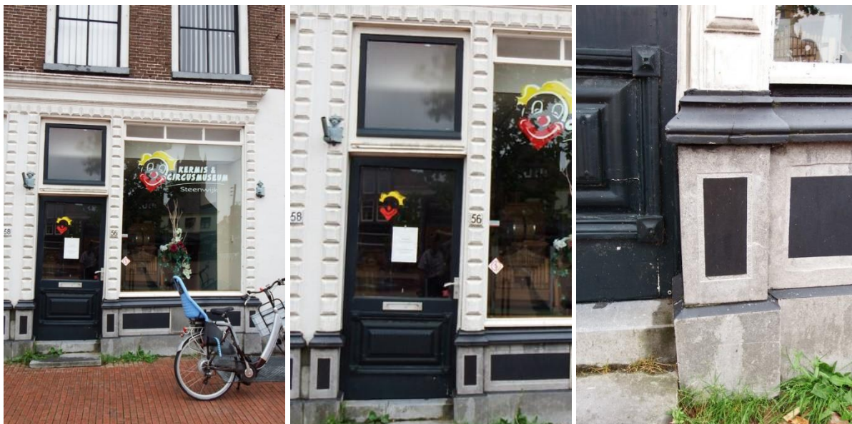
23: Rechter gedeelte van de spiegelsymmetrisch ingedeelde winkelpui. Links een overzicht, in het midden de glasdeur met borstweringspaneel en rechts een detail van het basement onder de etalageruit.
