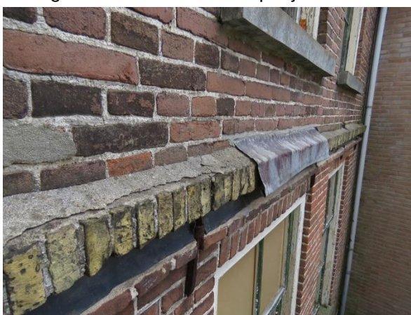
5: Gemetselde lijst in het metselwerk als fundering voor de verhoging van de rechterzijgevel.
