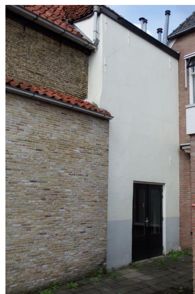
24: Gepleisterde linker zijgevel van bouwdeel A en het aansluitende gemetselde bouwdeel B (achterhuis)
