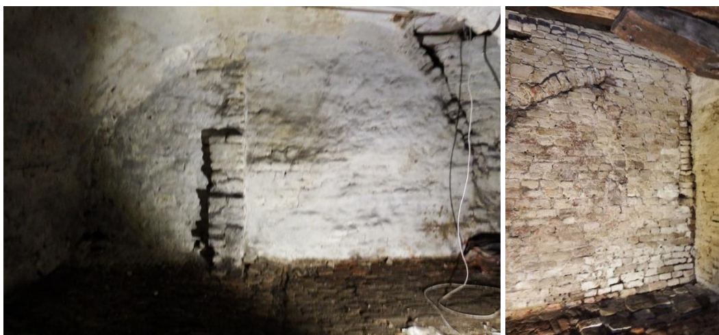
10: Achterwand van de tongewelfkelder. Links vanuit de overwelfde ruimte en rechts in de ruimte erachter.
