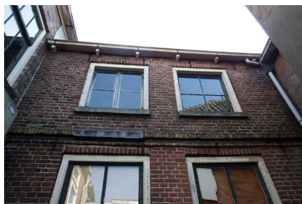
19: Verhoogde gedeelte van de rechter zijgevel met 4-ruits vensters. Eronder de in 1870 herbouwd gevelgedeelte met 6-ruits vensters.
