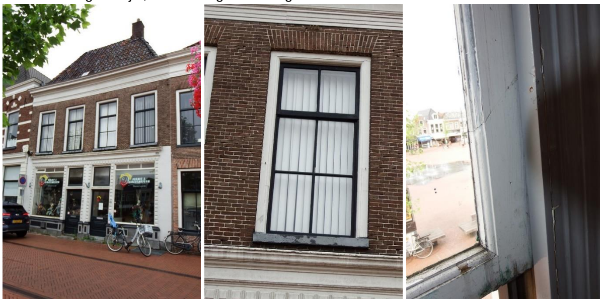
22: Voorgevel aan de Markt. Links een overzicht, in het midden een 6-ruits schuifvenster op de tweede bouwlaag met verengde stijlen en rechts het schuifraam met aangescherfd raamhout.
