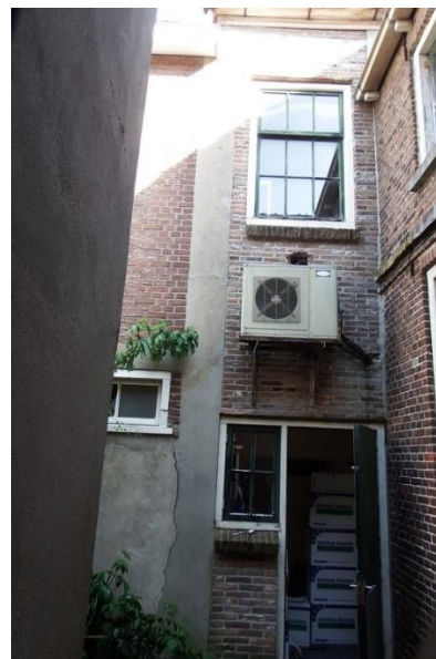
25: Gemetselde achtergevel van bouwdeel A uitgevoerd als spouwmuur in halfsteens verband met hergebruikte bakstenen.
