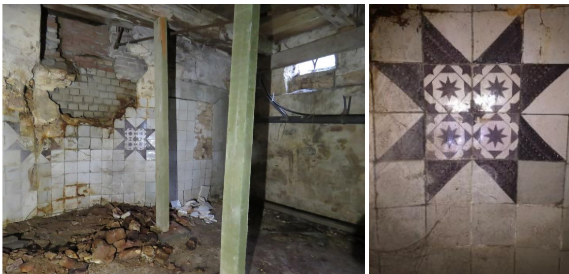
43: Links het restant van de achterwand met betegeling waarin een tableau is uitgespaard en rechts een detail van het stervormige tableau.
