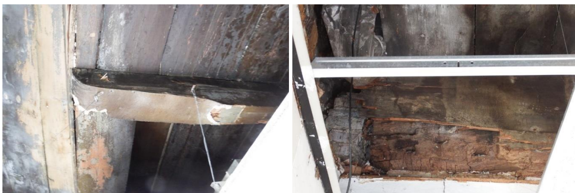
35: balklaag plafond eerste balklaag. Links de aan een onderslag opgehangen balk met ojiefvormig uiteinde ne rechte de als latei in de achtermuur ingemetselde gebintstijl.
