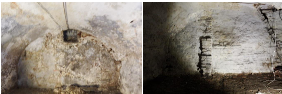
26: kelderruimte met tongewelf. Links het aanzicht naar de voorgevel en rechts vanuit de voorgevelzijde.
