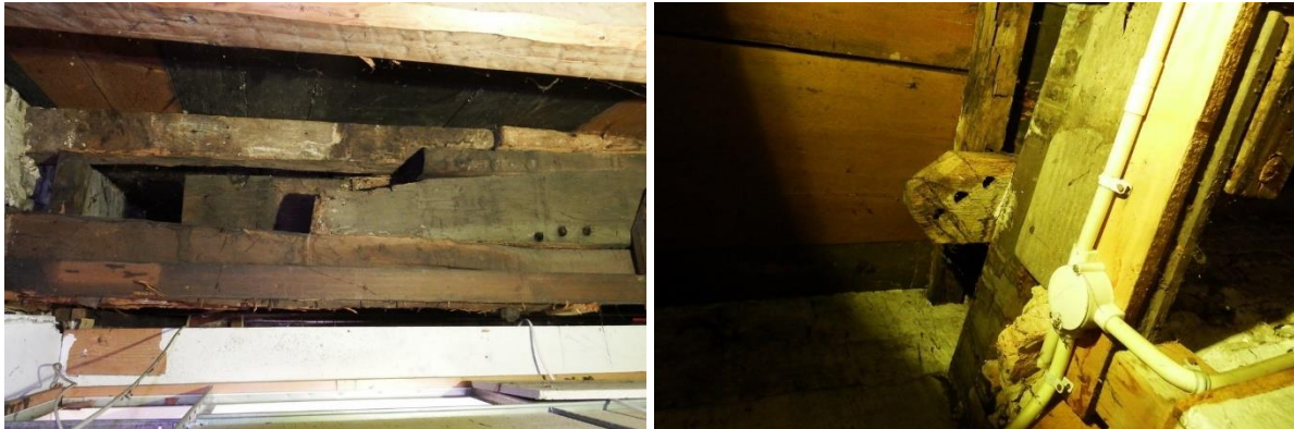
11: Gebintconstructie boven het plafond. Links de gebintbalk (met drie toognagelgaten) opgelegd op een ingemetselde console en voorzien van een spiebout. Rechts het uiteinde van (waarschijnlijk) een korbeel (drie toognagelgaten) gebruikt als raveling voor de schoorsteenmantel.
