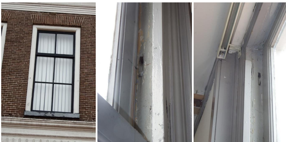
13: 6-ruits schuifvenster in de voorgevel met verlenging van de stijl en aan de binnenzijde aanwezige posities van de katrollen.
