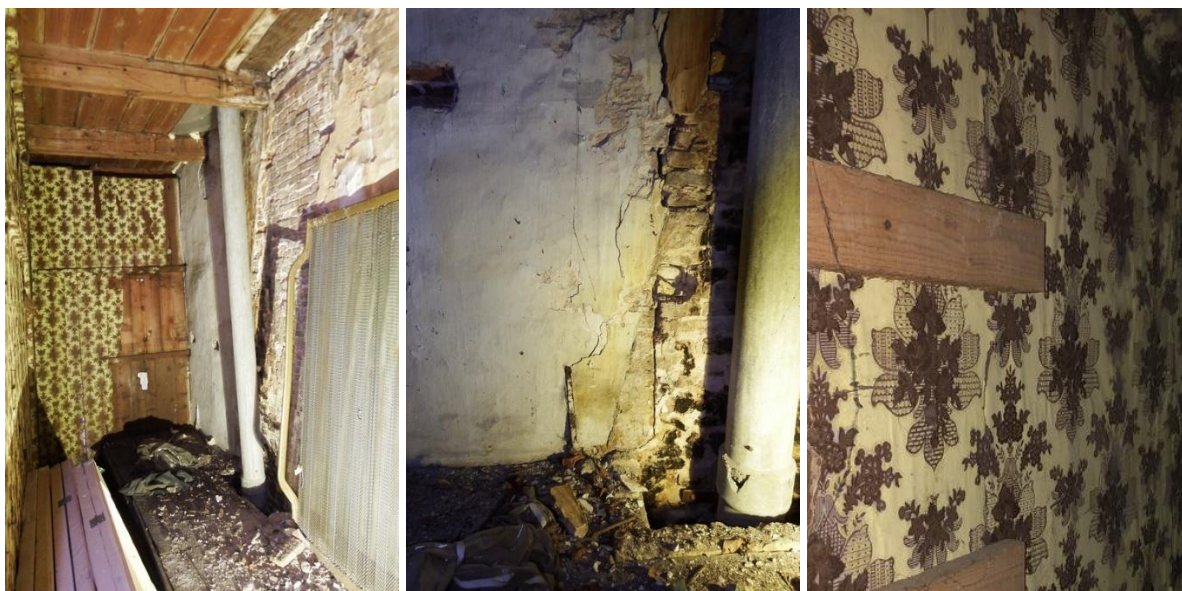
38: Berghok tegen de linker zijgevel. Links een overzicht naar de voorgevel, in het midden de versleping op de bouwnaad en recht een detail van het aanwezige behang.
