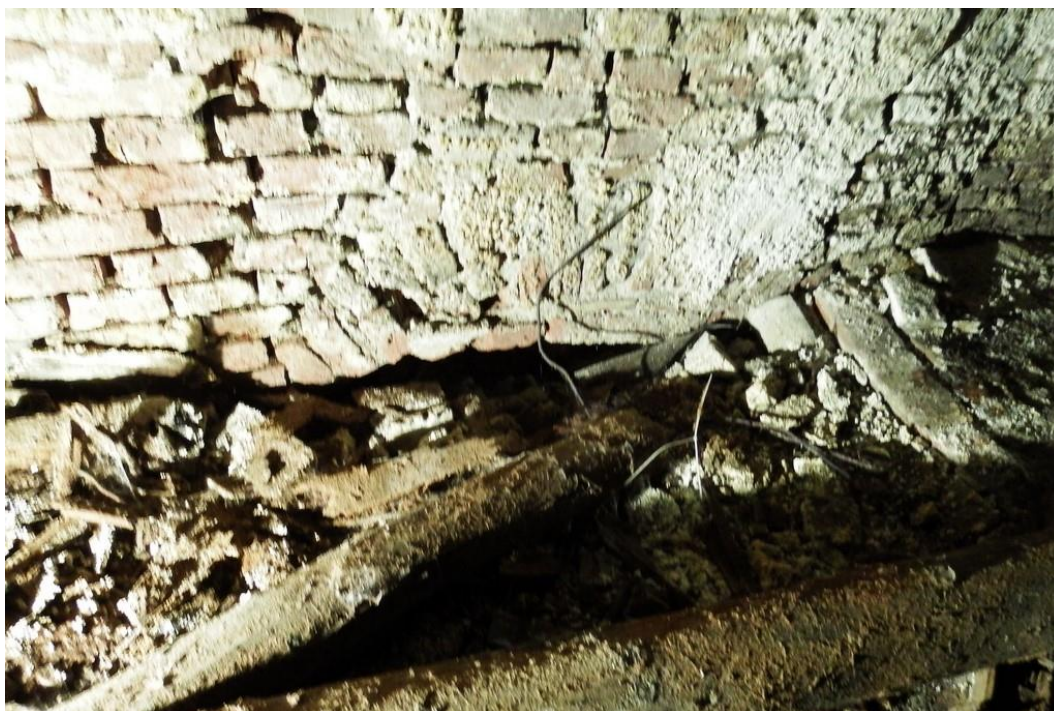
16: Spaarboog op vloerniveau in de rechter zijwand met aan de voorzijde (rechts) het spoor van de fundering.
