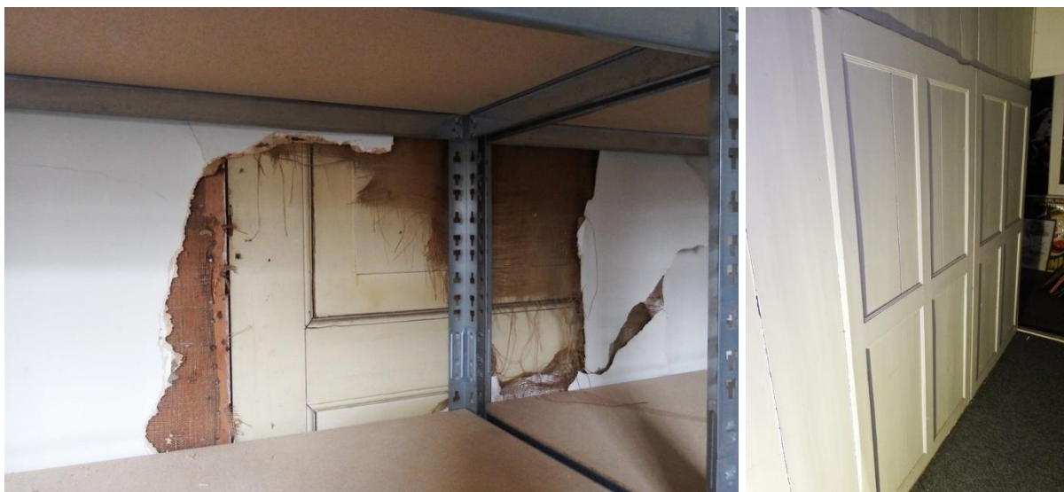
37: in de houten wand verwerkte deuren. Links een enkele loopdeur en rechts twee ensuite deuren. Het vertrek is aan de binnenzijde voorzien van een jutebespanning waarop behang is aangebracht.
