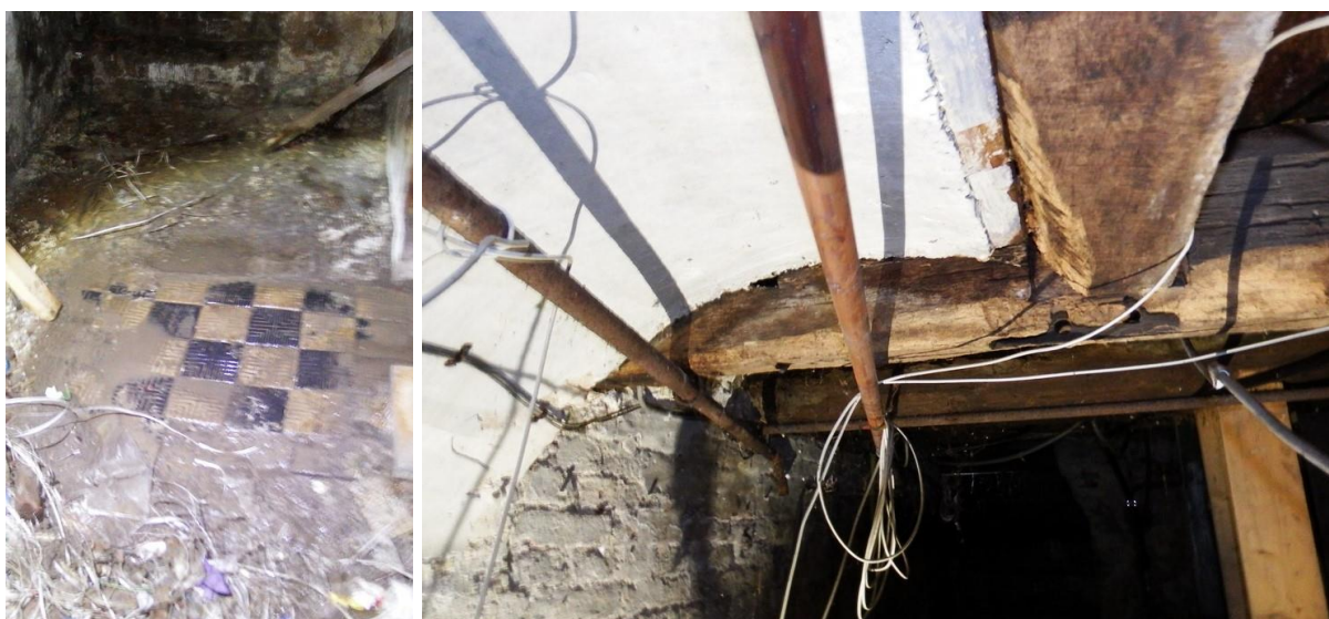
28: Vloer van gres tegels voor de buitentrap (links) en een haardgewelf (rechts) in een raveling samengesteld uit hergebruikt balkhout.
