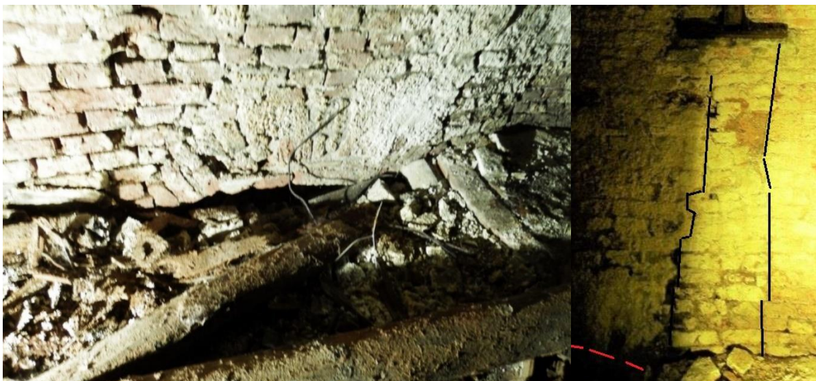
31: De overkluizing in de rechter zijmuur aansluitend op de aanzet van de achtergevel. In rood gestippeld de overkluizing en in zwart de contour van de achtergevel.
