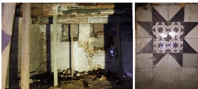
3: Reconstructie van de huizen Markt 56 en 60 rond 1700 met geheel links het net gebouwde achterhuis. In het midden het restant van de achterwand met betegeling die niet doorloopt tot in de hoek en rechts een detail van het stervormig tableau.
