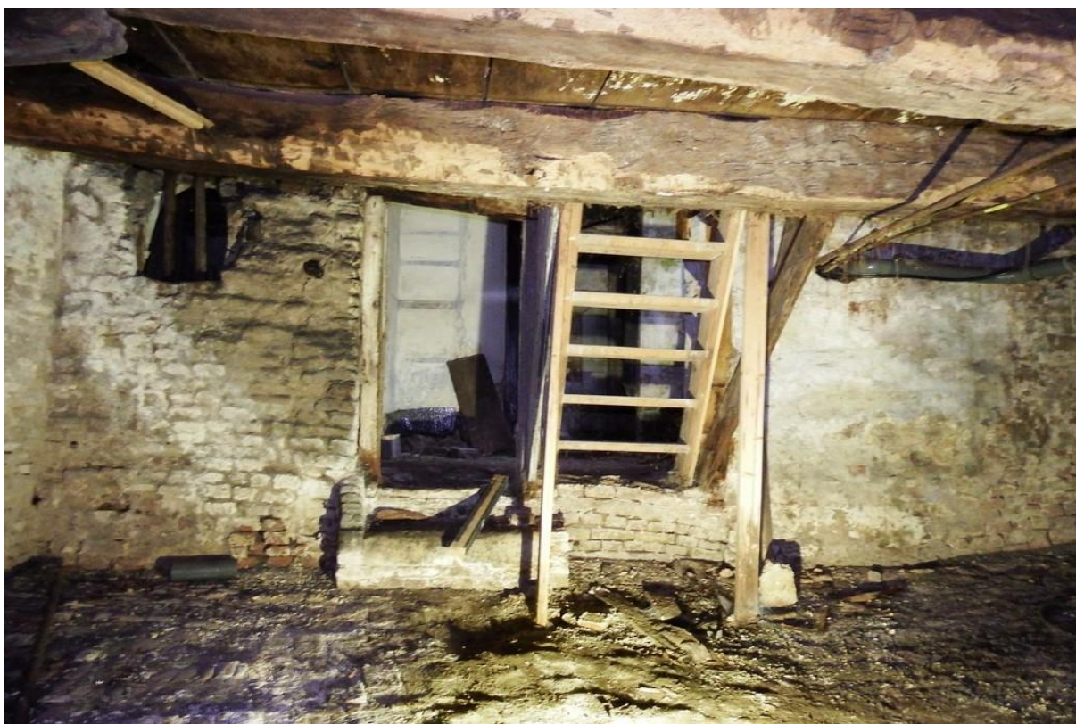
32: achterwand van de kelder met links de rondboogopening met houten diefijzers en centraal de toegang tot de kelder.
