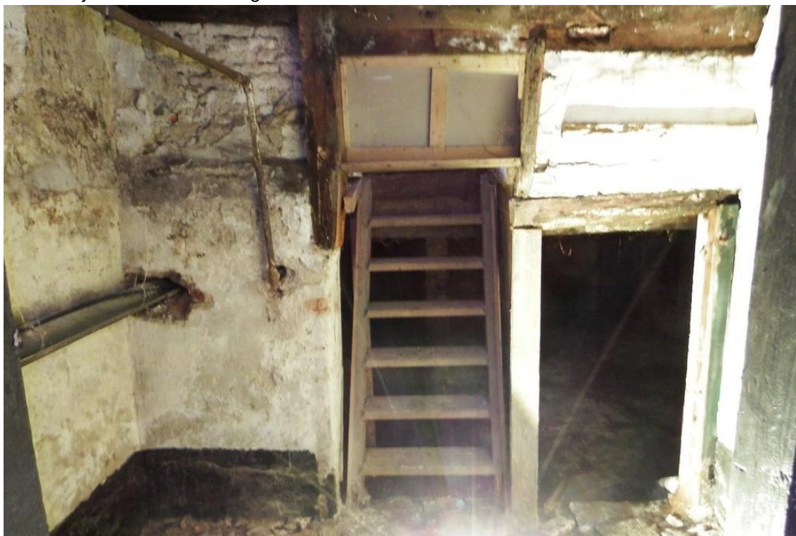
44: Kelderingang gezien naar de voorgevel. In het linker uiteinde van de balk is een zwaluwstaartvormige uitkeping aanwezig. De rechter stijl naast de trap bezit glas in lood sponningen.
