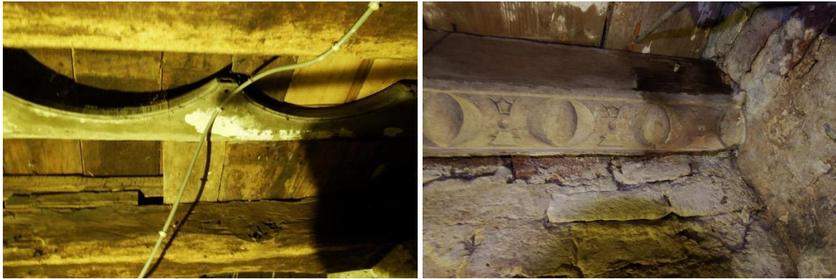
30: Bouwfragmenten. Links een gedeelte van de latei van een winkelpui en rechts het uiteinde van een gevellijst, uitgevoerd als eierlijst.
