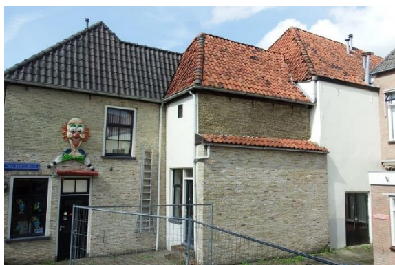
20: Gevelgedeelte onder het lessenaarsdakje dat in 1987 voor de bouwsporen van de in 1982 afgebroken stadsboerderij is geplaatst.
