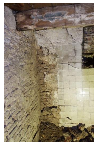
4: Verlenging van de achterwand zonder wandtegels.
