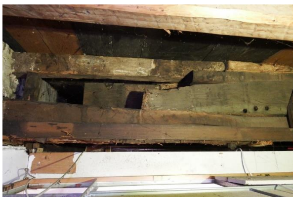
34: Gebintconstructie boven het plafond. Links de gebintbalk (met drie toognagelgaten) opgelegd op een ingemetselde console en voorzien van een spiebout. Rechts het uiteinde van (waarschijnlijk) een korbeel (drie toognagelgaten) gebruikt als raveling voor de schoorsteenmantel.
