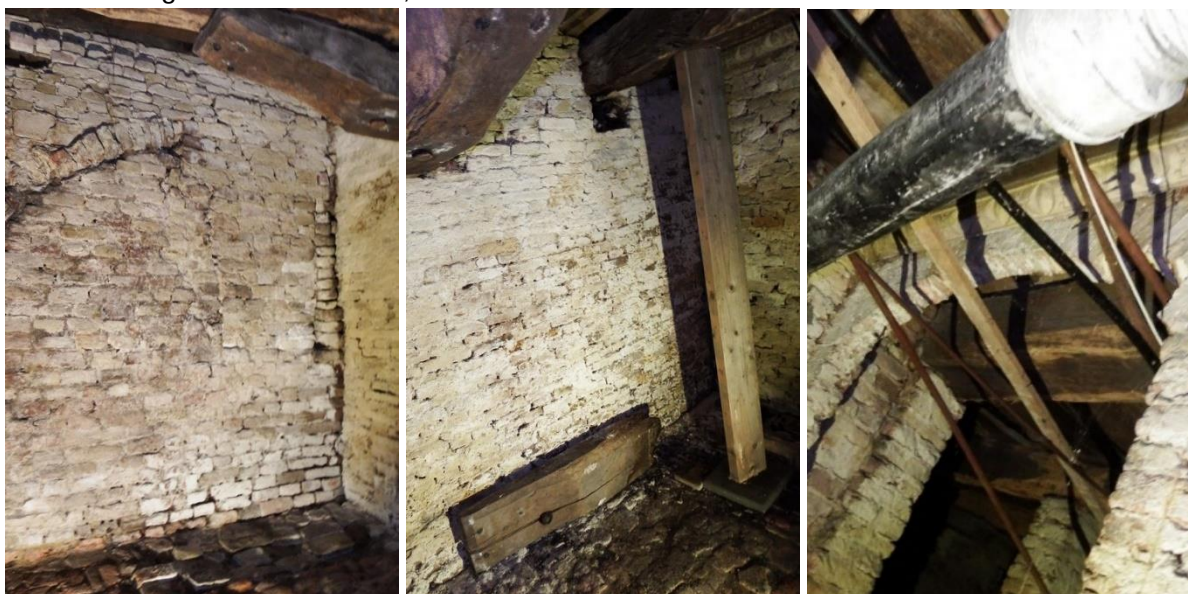
29: Links de buitenzijde van de achterwand van de tongewelfkelder met de gedeeltelijk zichtbare gewelfvorm dat een aanheling is van de oorspronkelijke ruimte, in het midden een balkopleging op een console en rechts de doorgang in de tussenmuur met op de achtergrond de poeren en het aansluitende metselwerk.
