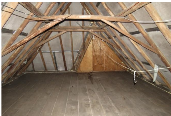
46: Zolderruimte boven de tweede bouwlaag gezien naar de achtergevel.
