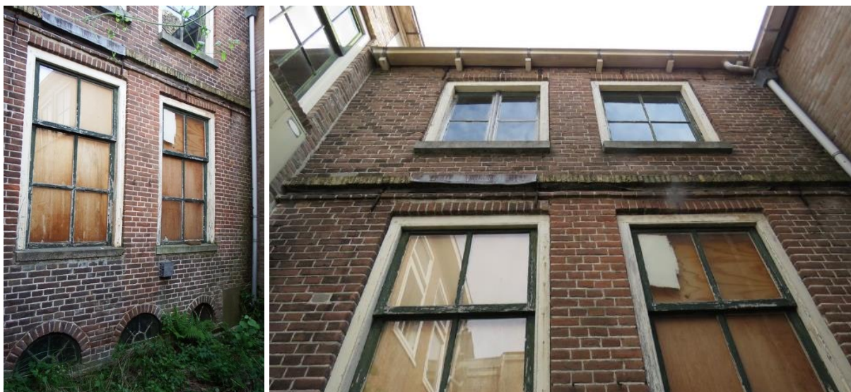
41: Rechter zijgevel, met links de vensters van het souterrain en de eerste bouwlaag en rechts die van de tweede bouwlaag.
