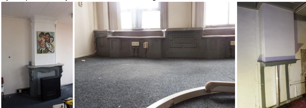
36: Interieur elementen op de tweede bouwlaag. Links de schoorsteenmantel tegen de linker zijwand, in het midden de vensterbankbetimmering onder de vensters van de voorgevel en rechts de keukenschouw.
