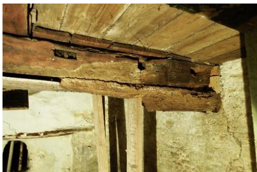
STABU codering 24 RUWBOUWTIMMERWERK
