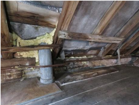
STABU codering 24 RUWBOUWTIMMERWERK
