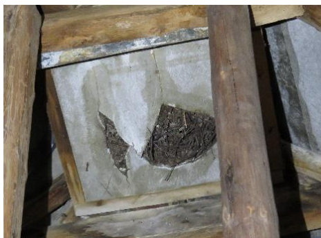
STABU codering 24 RUWBOUWTIMMERWERK
