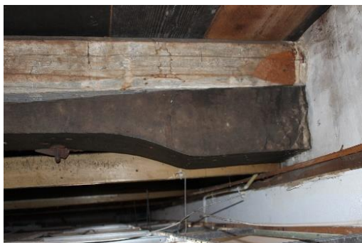
STABU codering 24 RUWBOUWTIMMERWERK
