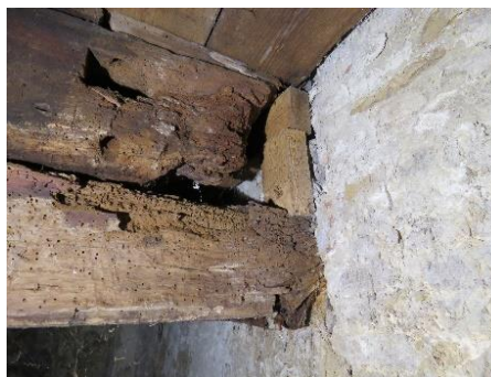
STABU codering 24 RUWBOUWTIMMERWERK
