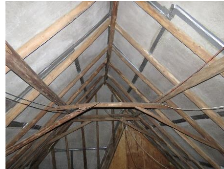
STABU codering 24 RUWBOUWTIMMERWERK
