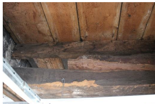
STABU codering 24 RUWBOUWTIMMERWERK
