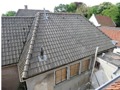
STABU codering 33 DAKBEDEKKINGEN
