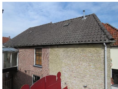
STABU codering 33 DAKBEDEKKINGEN
