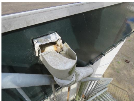
STABU codering 33 DAKBEDEKKINGEN
