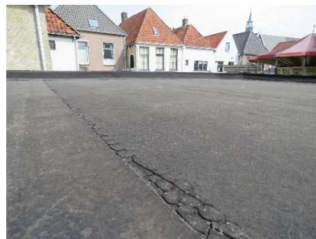
STABU codering 33 DAKBEDEKKINGEN
