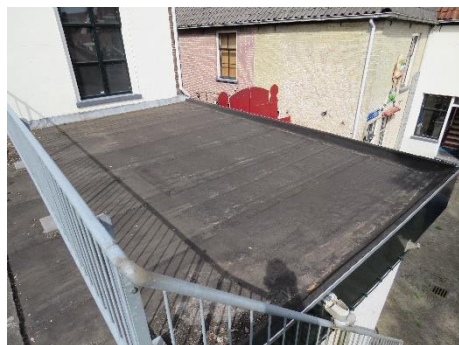
STABU codering 33 DAKBEDEKKINGEN
