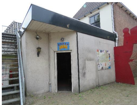
STABU codering 33 DAKBEDEKKINGEN
