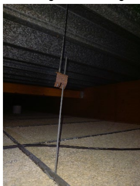
5.1c ophanging systeemplafond (N43, N59 en N90)
