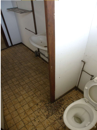
Boven, vogelschade ventilatiekanaal bij het toilet van de oude kantine
