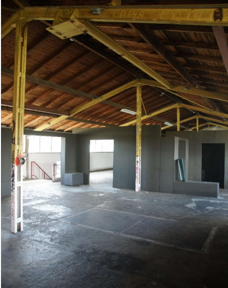
Boven links; kantoorruimten, rechts; spanten opgedikt stramien 7 west
