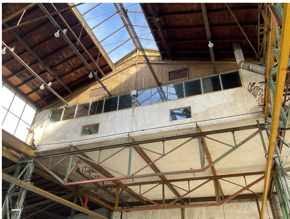
Foto 1190: De 2 e verdiepingsvloer die de hal "insteekt"
