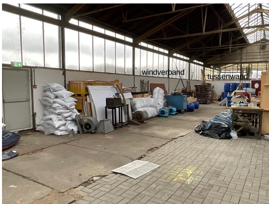
Foto 1232: Zijgevel met 1 van de windverbanden en rechts de tussenwand
