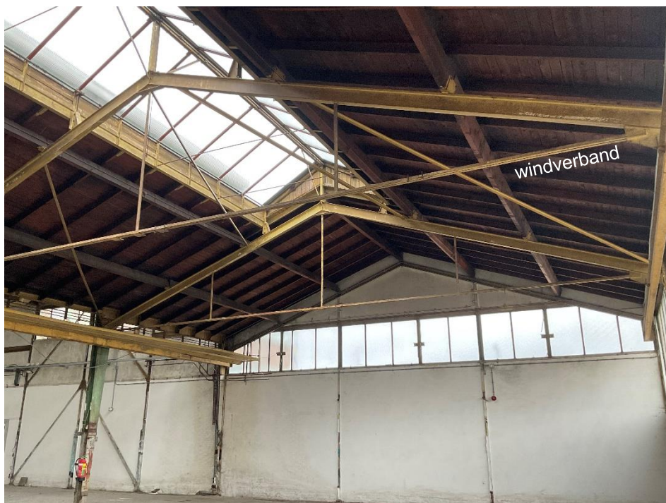
Foto 1258: Zijbeuk met zadeldak, waarbij het windverband in het dak in het één na laatste stramien te zien is
