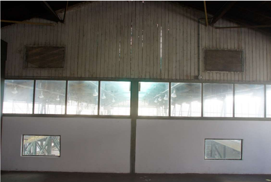
Boven, uitkragend deel kantoren in de hal
