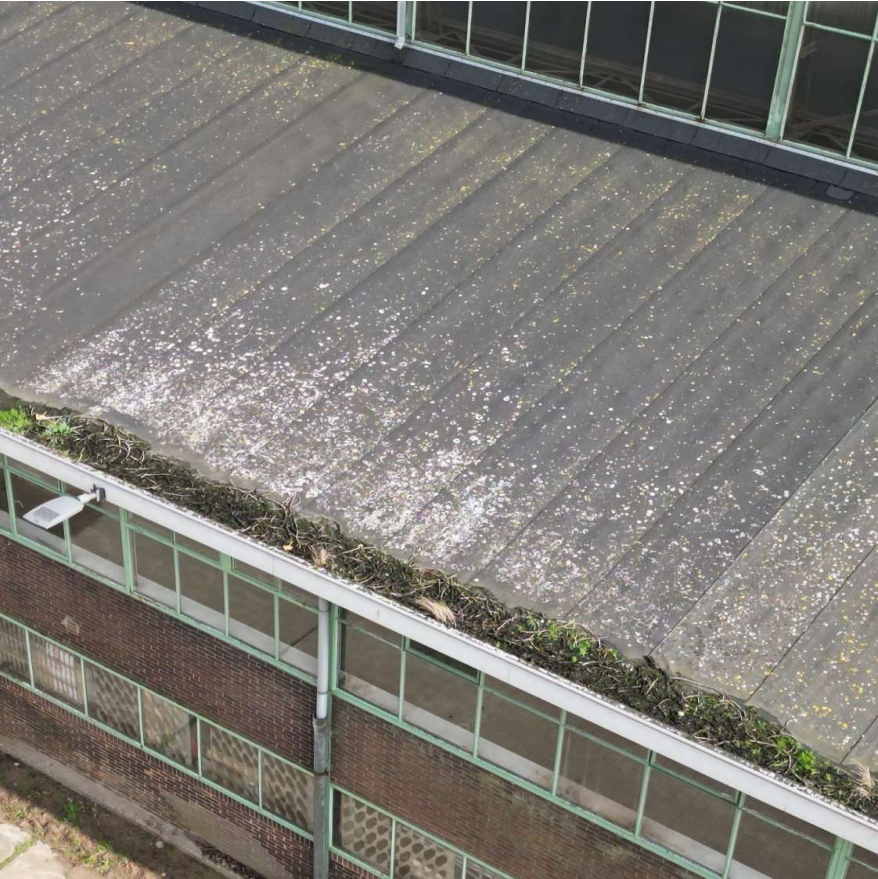
Boven, verstopping goot cq nestmateriaal westzijde
