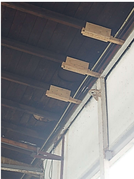
Boven links; kantoorruimten, rechts; spanten opgedikt stramien 7 west
