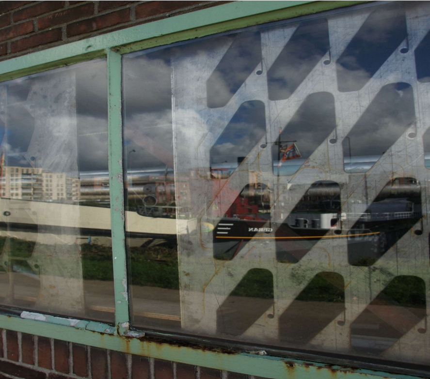
Boven/ onder, kozijnen van T-profielen stopverf slecht. Onderdorpels slecht
