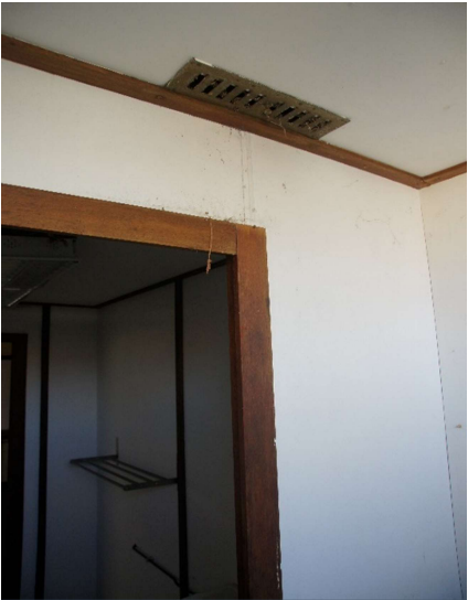
Boven, vogelschade ventilatiekanaal bij het toilet van de oude kantine
