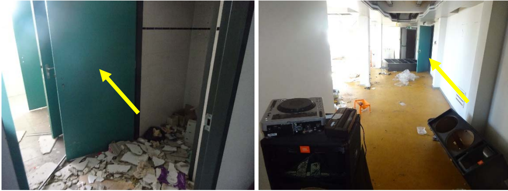
Foto 9: Plafonds zijn vervaardigd van beton en verlaagd met zachtboardplaten (niet asbestverdacht)
