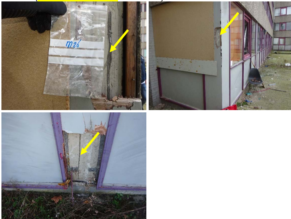
Foto 6: Smeerlaag tegen het betonnen constructie van het kantoorpand ( niet asbesthoudend / zie M-26)
