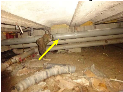
Foto 13: PVC standleidingen en riolering (niet asbestverdacht)
