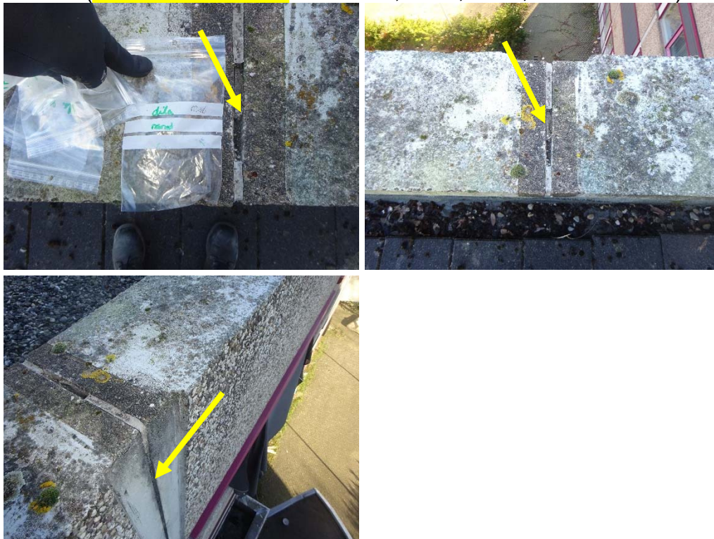
Foto 2: Dilatatiekits toegepast op diverse plaatsen (niet asbesthoudend / zie M-04, M-06, M-07, M-10 en M-11)
