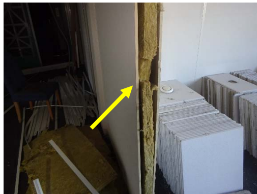
Foto 12: Tussenwanden op de verdiepingen zijn vervaardigd van gipsplaat (niet asbestverdacht)
