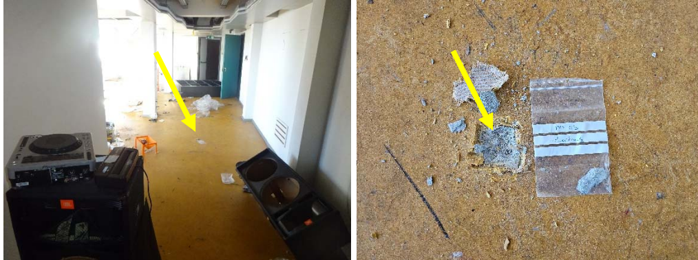
Foto 1: Vloerlaag door het gehele kantoorpand (niet asbesthoudend / zie M-03 en M-16)
