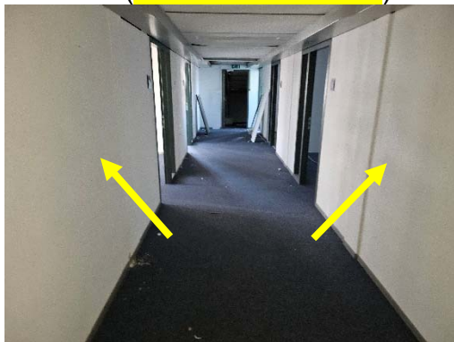
Foto 12: Tussenwanden op de verdiepingen zijn vervaardigd van gipsplaat (niet asbestverdacht)
