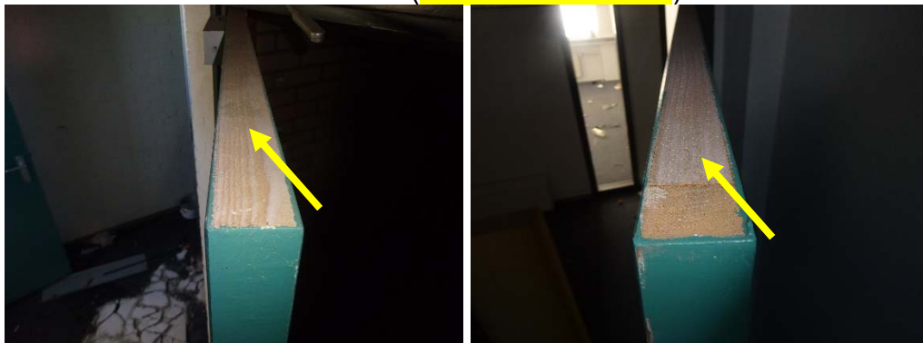
Foto 8: Nieuwe houten deuren ( niet asbestverdacht )
