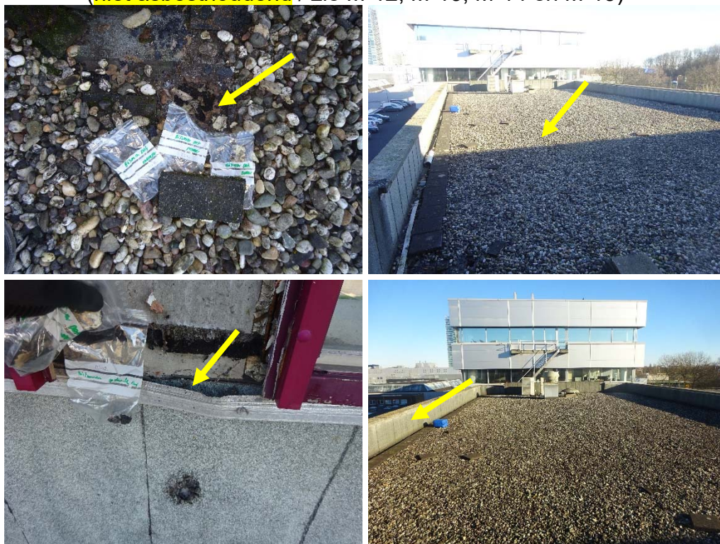
Foto 4: Bitumen toegepast tegen de opstaande randen en de daken (niet asbesthoudend / zie M-12, M-13, M-14 en M-15)
