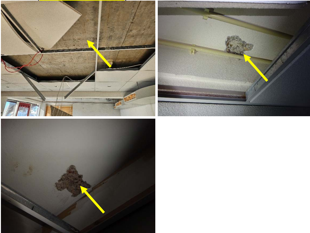
Foto 9: Plafonds zijn vervaardigd van beton en verlaagd met zachtboardplaten (niet asbestverdacht)
