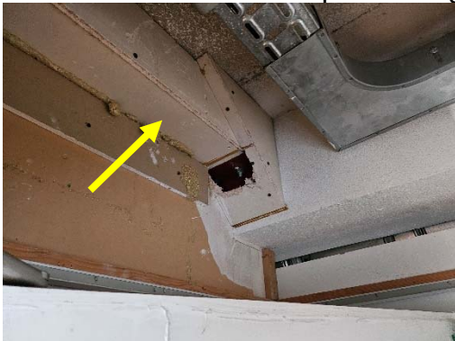
Foto 10: Houtwolcementplaten toegepast op diverse plaatsen (niet asbestverdacht)
