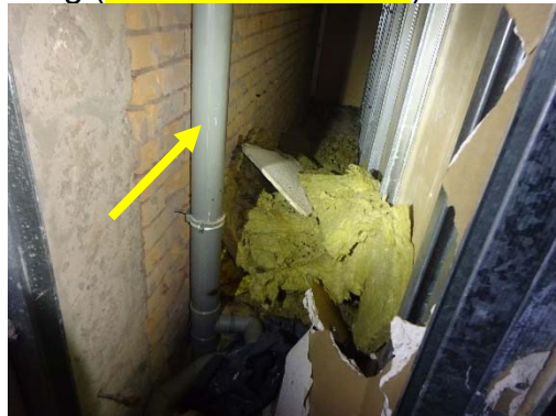
Foto 13: PVC standleidingen en riolering (niet asbestverdacht)
