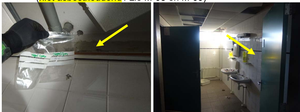
Foto 3: Tegellijm toegepast bij de sanitaire voorzieningen (niet asbesthoudend / zie M-08 en M-09)
