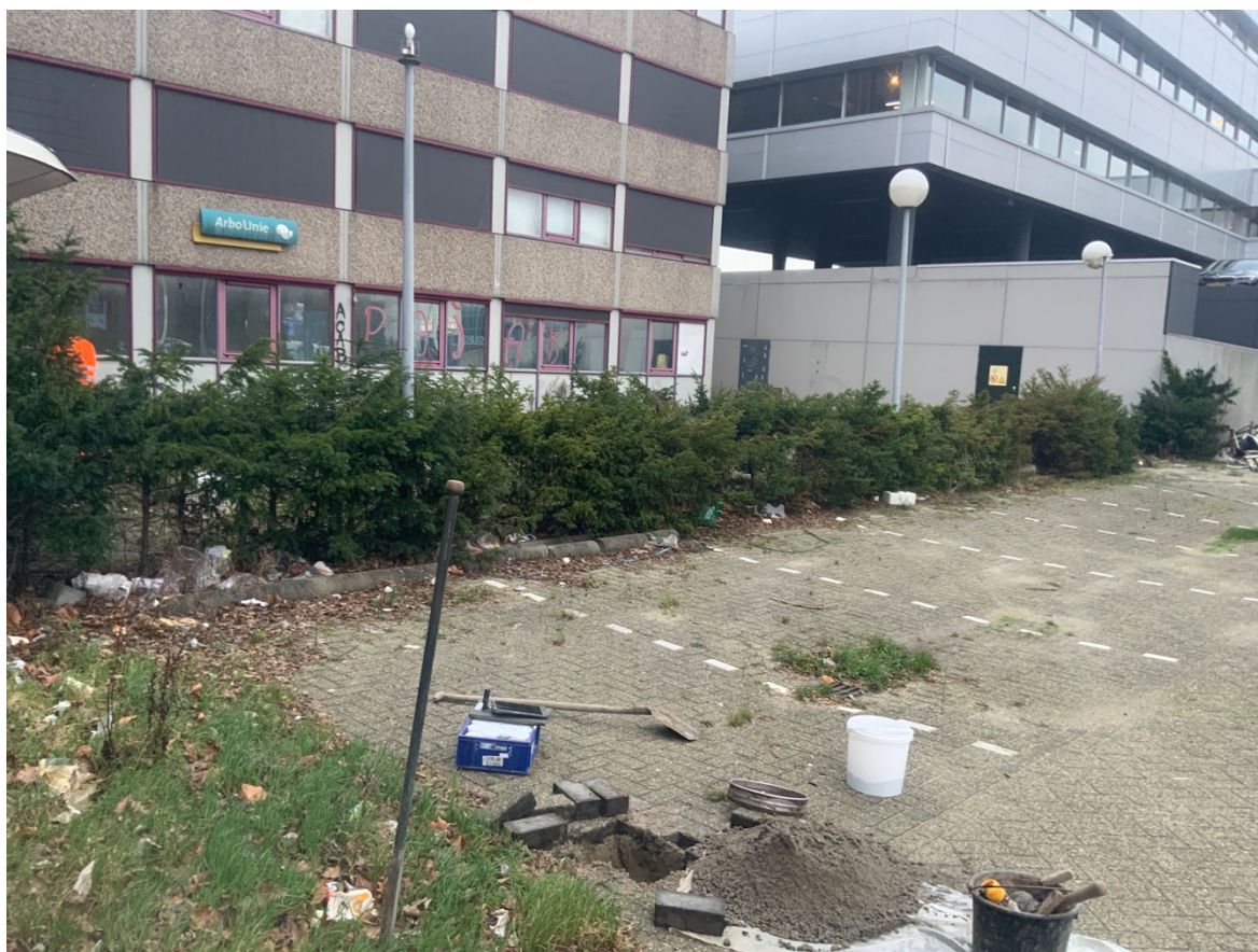
Foto 1: Zuidoostelijke centrale deel onderzoekslocatie in noordelijke richting
