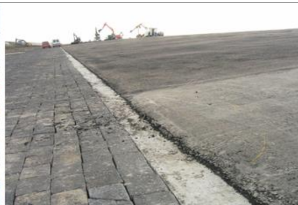
Een teenconstructie in aanbouw (Links) en afgeronde overgangsconstructie (rechts)
