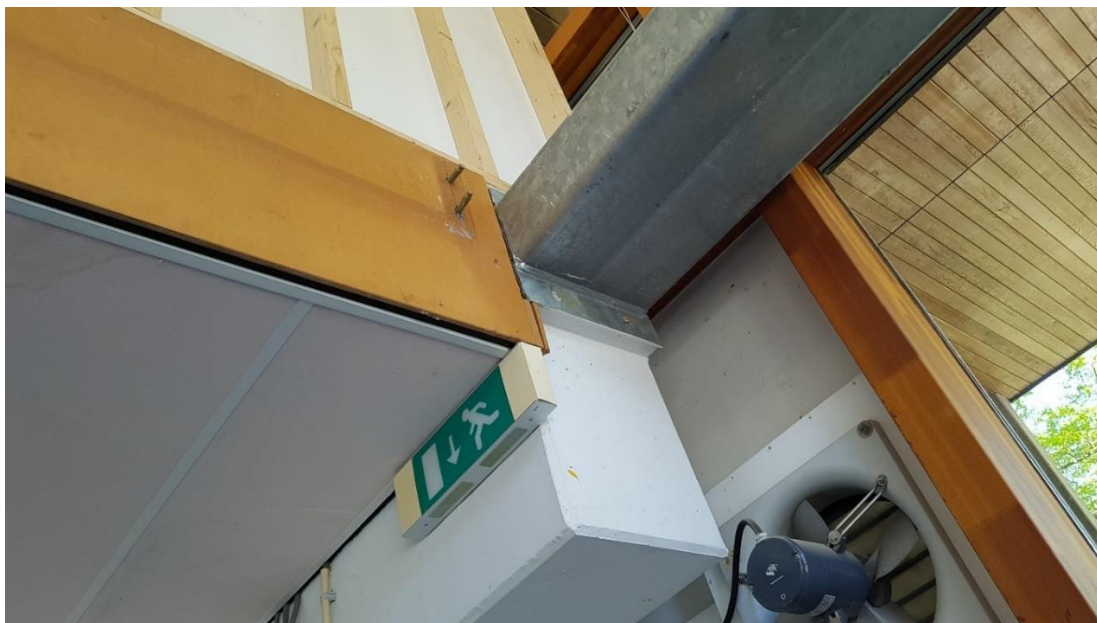
Afgeslepen bouten bij koppeling stalen ligger
