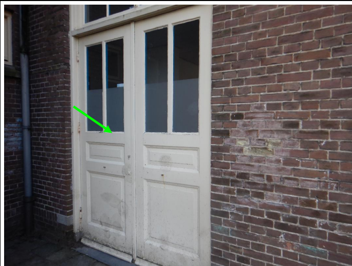
Foto 10: Asbestvrije stopverf in achtergevel begane grond (1-5: M05a-V en M05b-V)
