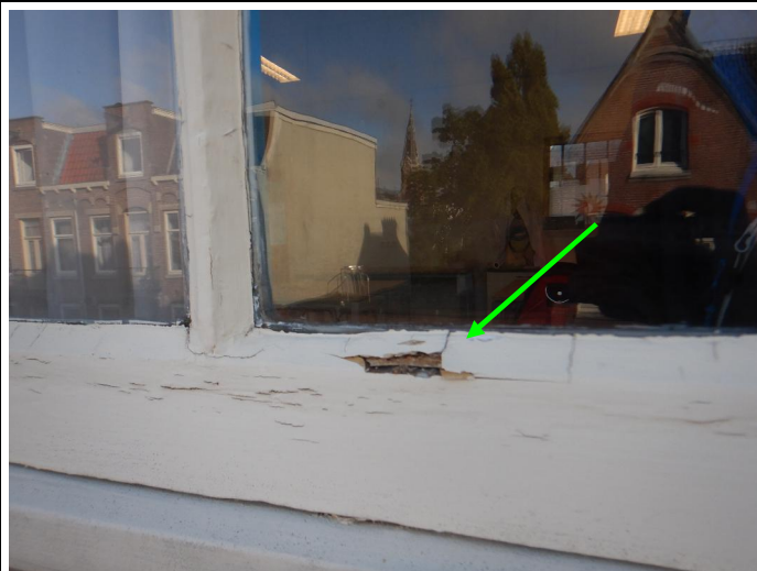
Foto 4: Asbestvrije stopverf in vast raam op 2 e verdieping (1-2: M02a-V en M02b-V)
