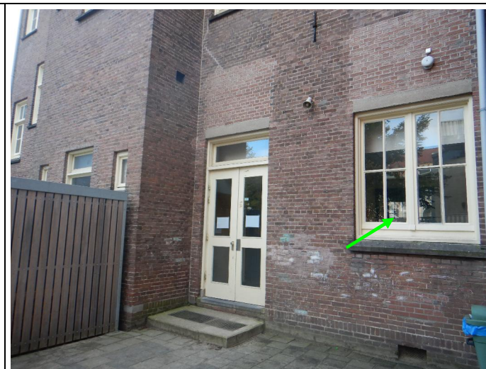
Foto 9: Asbestvrije stopverf in achtergevel begane grond (1-5: M05a-V en M05b-V)
