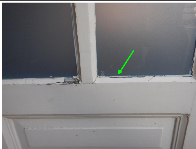
Foto 11: Asbestvrije stopverf in achtergevel begane grond (1-5: M05a-V en M05b-V)
