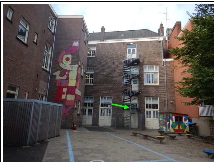
Foto 13: Asbestvrije stopverf in kozijnen noodtrap (1-7: M07a-V en M07b-V)
