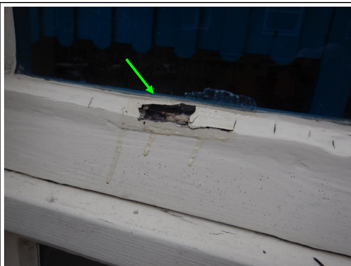
Foto 7: Asbestvrije stopverf in vast raam op 1 e verdieping (1-4: M04a-V en M04b-V)
