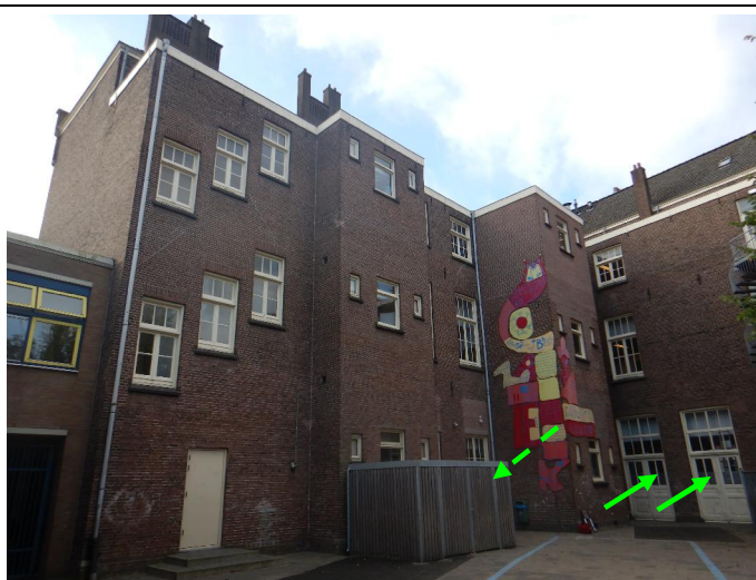
Foto 8: Asbestvrije stopverf in achtergevel begane grond (1-5: M05a-V en M05b-V)
