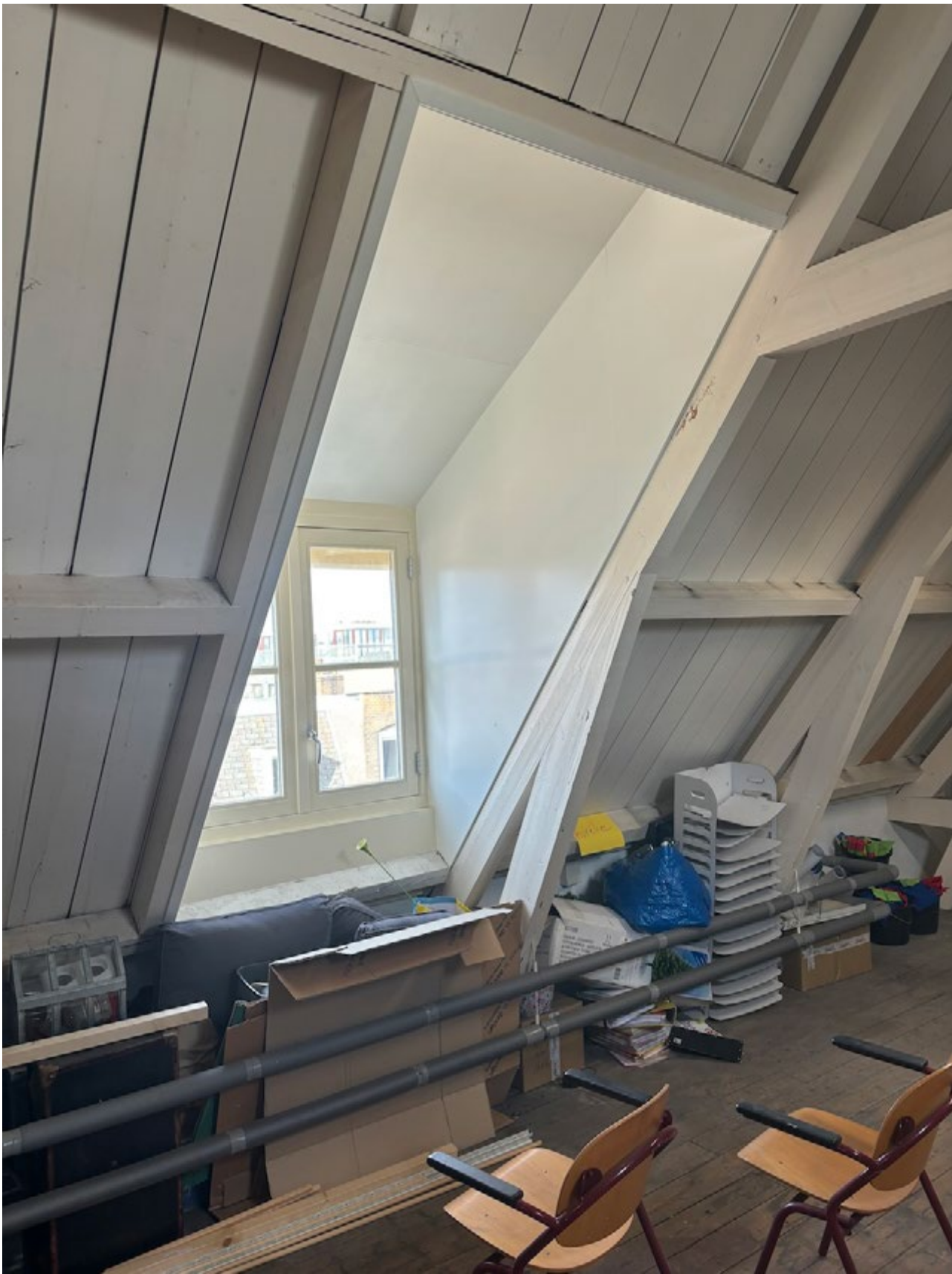
Detail bestaande dakkapel
