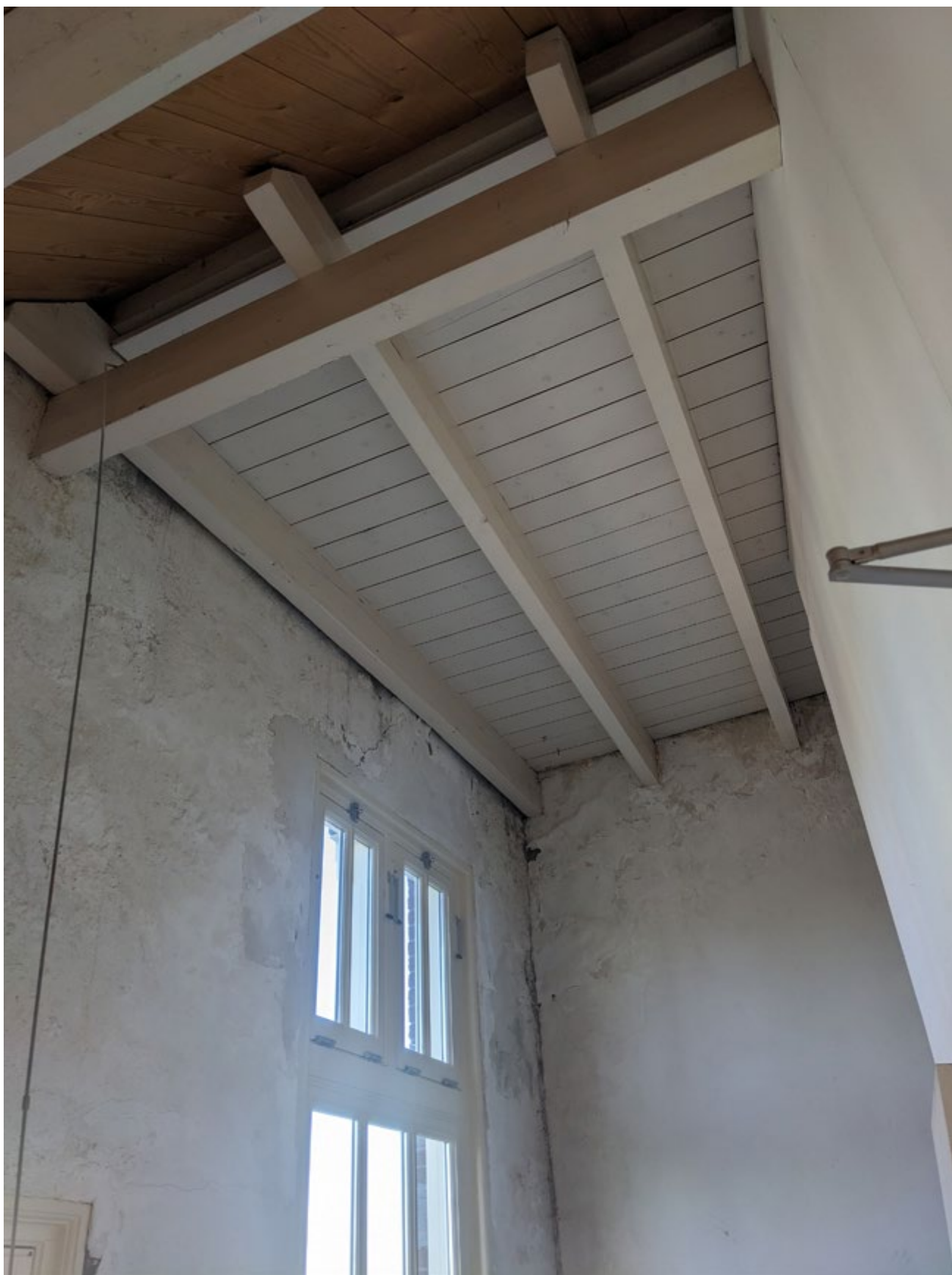
Detail plat dak en gevel trapdeel
