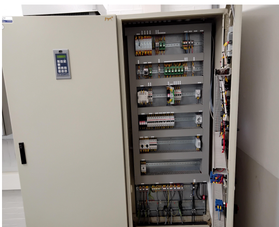
geen asbestverdacht materiaal aangetroffen in de elektrakasten
