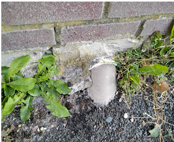
riolering van het toilet van pvc
