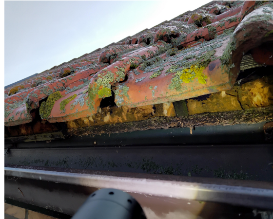
geen asbestverdacht materiaal aangetroffen bij de dakgoot en bij het dakbeschoot
