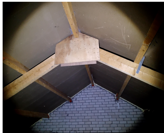
geen asbestverdacht materiaal aangetroffen op de zolder
