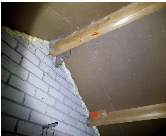
geen asbestverdacht dakbeschot aangetroffen
