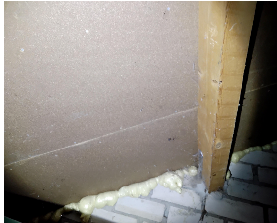
geen asbestverdacht dakbeschot aangetroffen
