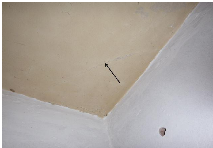
Beschadiging plafondbeplating
