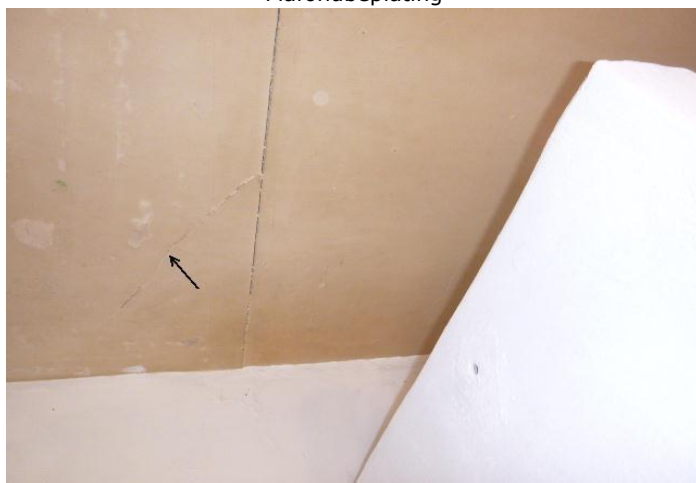
Beschadiging plafondbeplating
