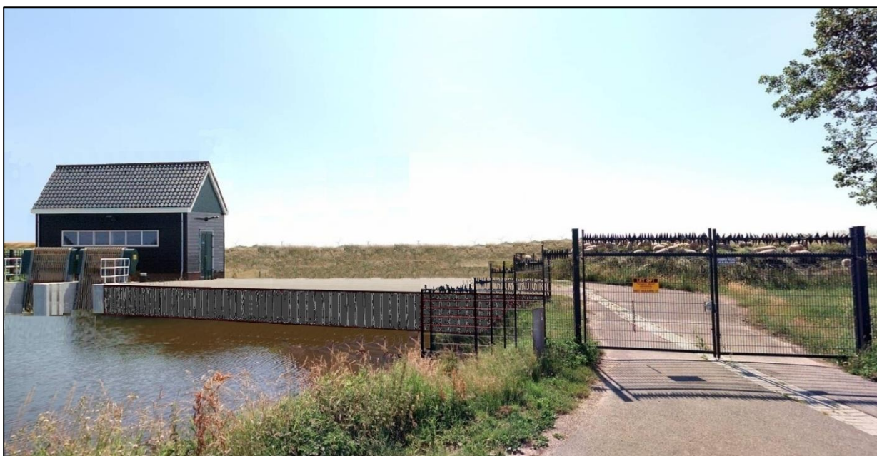
Impressie nieuwe gemaal Hippolytushoef
