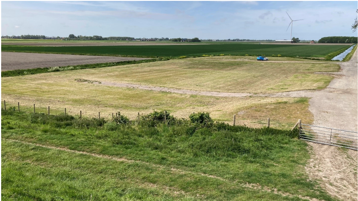
Figuur 7: Het terrein waar het gemaal wordt gebouwd en de maalkom wordt gegraven. Achter de auto bevindt zich de molenfundering
