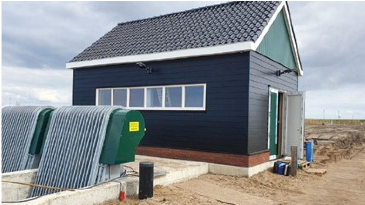
Figuur 5: Gemaal Waard-Nieuwland in aanbouw. Details, waaronder het rooster aan de voorkant wijken af van de methode die bij gemaal Van der Sterr gebruikt gaat worden.
