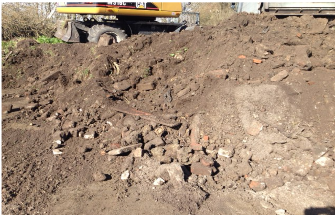
foto 02 ontgraving puinfundatielaag
