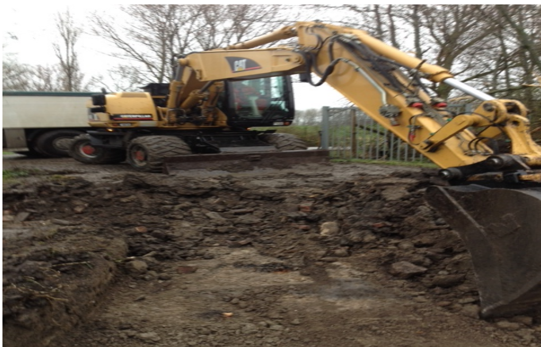
foto 04 ontgraving puinfundatielaag
