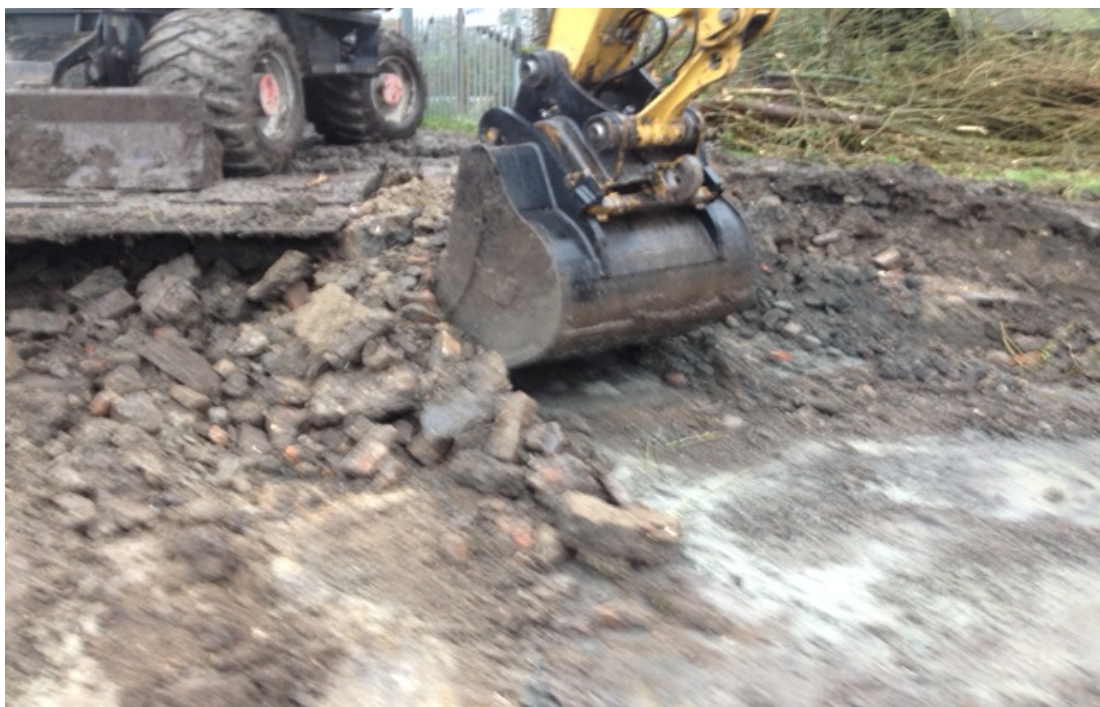
foto 03 ontgraving puinfundatielaag
