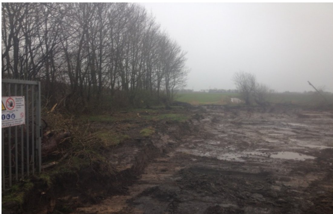
foto 07 totale ontgraving ca 0,7 m-mv.
