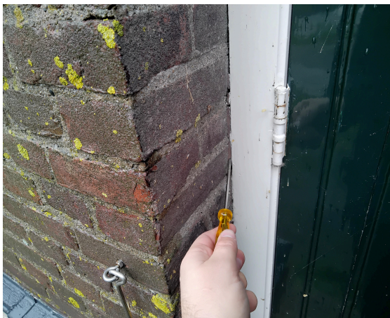
kit langs het deurkozijn niet asbestverdacht.
