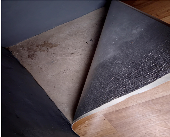
zeil is niet asbestverdacht.
