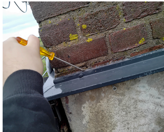
kit langs afwerking gevel is niet asbestverdacht.
