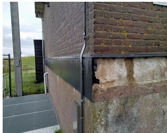
gevelafwerking is van Trespa.
