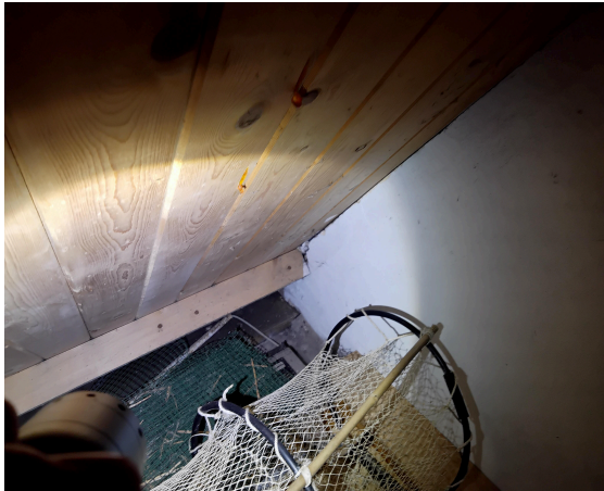
dakbeschot is niet asbestverdacht.
