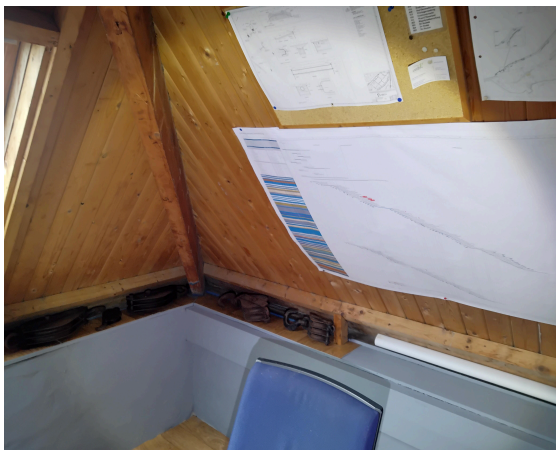
dakbeschoot is niet asbestverdacht.
