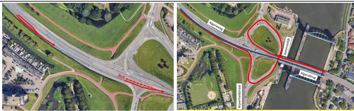
Afbeelding 4.2 Flessenhalsen avondspits Algerabrug (links) en de krakeling (rechts)
