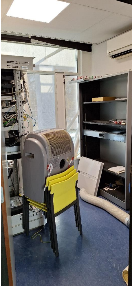
Figuur 6 Huidige indeling ruimte D, serverruimte
