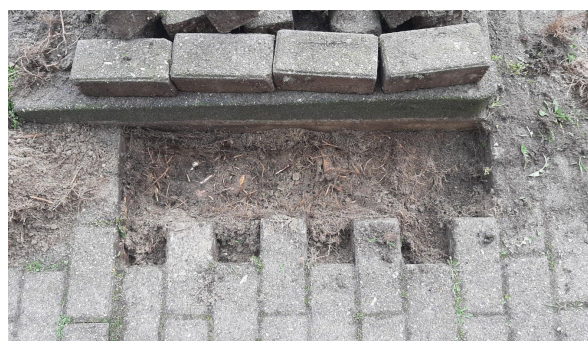
Afbeelding 12. Zeer intensieve beworteling onder het bestratingsoppervlakte.
