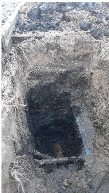
Afbeelding 13. Bodemopbouw onder de bestrating.
