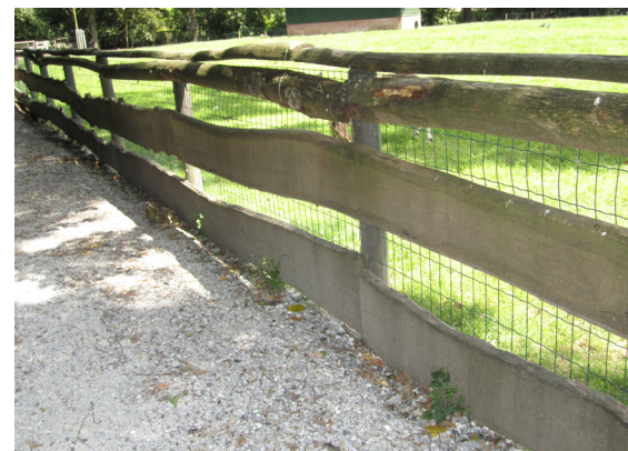
Voorbeeld houten hek in park
