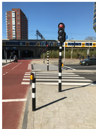
VRI voetgangers en fietsers, met standaard drukknop. Onderlichten ingebouwd in de mast.
