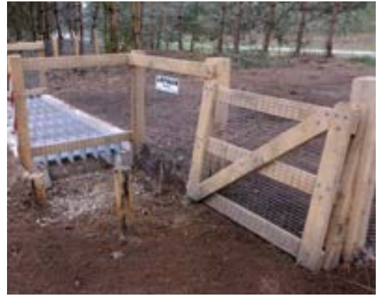
Raster sluit goed aan op het wildrooster. Er is een terugklappootje voor wandelaars en de palen naast het rooster zijn rood-wit gemarkeerd (Bron: Arfman)
