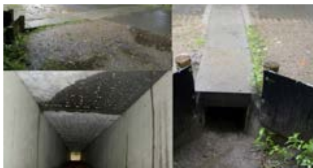
Een CAT-tunnel onder de Dochterenseweg in Lochem (Bron: Kies 2012)
