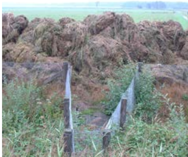
Goede afspraken met beheerders en eigenaren van aanpalende gronden voorkomt blokkades van faunatunnels, zoals in dit voorbeeld
