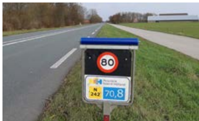
Roller op hectometerpaaltje ter voorkoming dat vogels hierop gaan zitten (Bron: Jasja Dekker Dierecologie)
