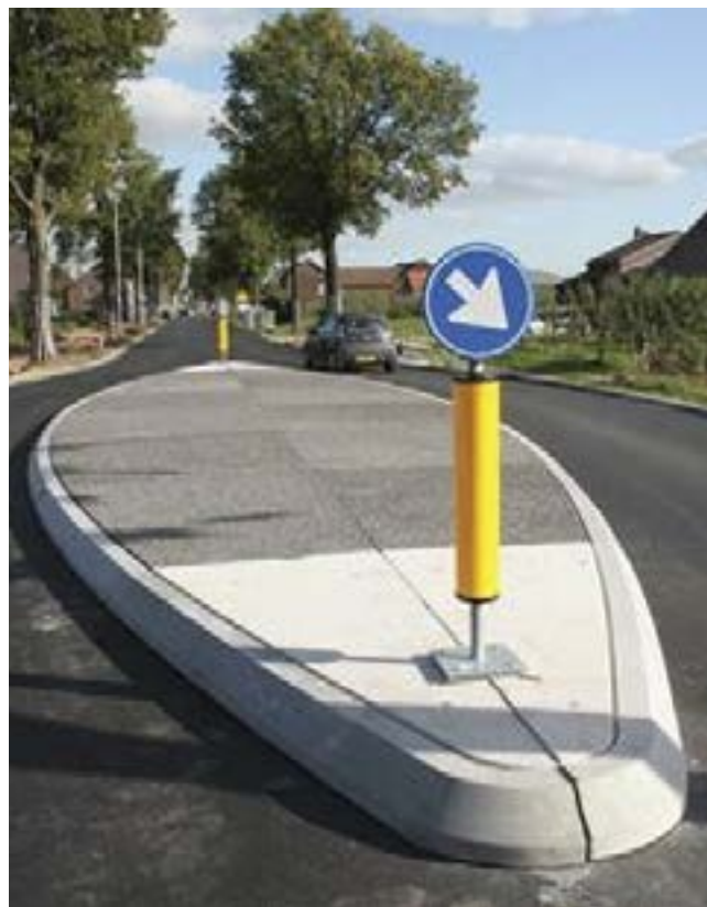
Een verkeerseiland als snelheidsremmende maatregel (Bron: CROW)
