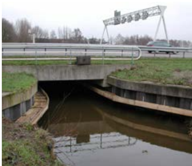
Viaduct met faunavoorziening in Cattenbroek (provincie Utrecht)
