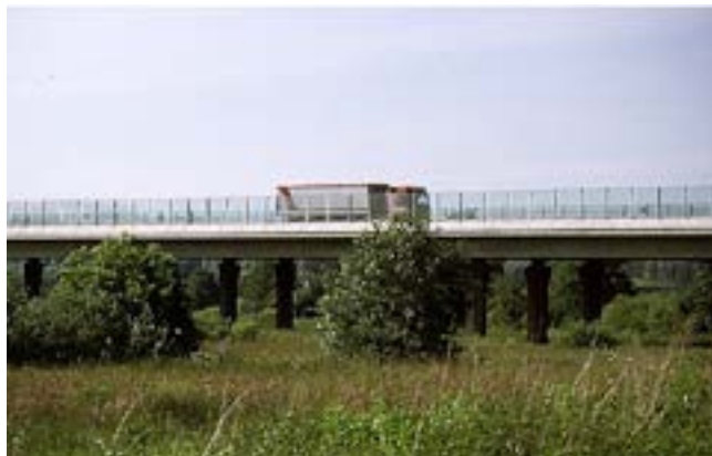
Groot viaduct: weg op palen (Mecklenburg - Vorpommern)
