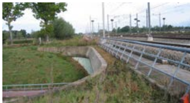
Medegebruik door fauna met behulp van groenstrook op spoorbrug (Bron: ProRail)
