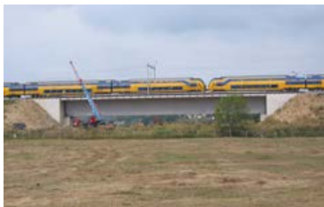
Brede onderdoorgang onder spoor (Bron: ProRail)
