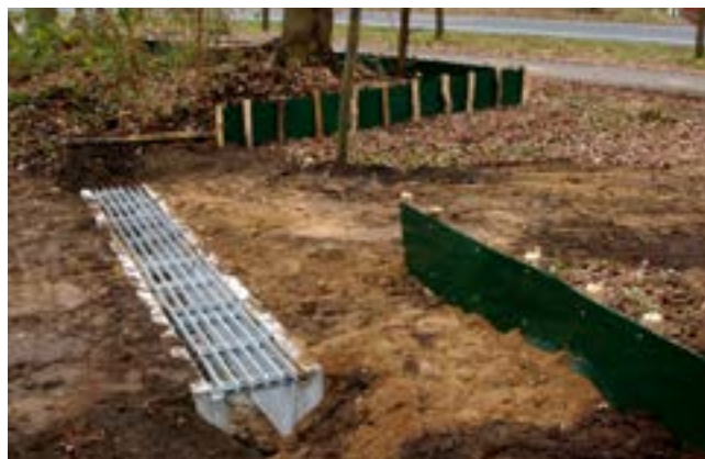
Kunststof is alleen geschikt voor tijdelijk schermen. Let op dat de palen aan de wegwand van het scherm staan
