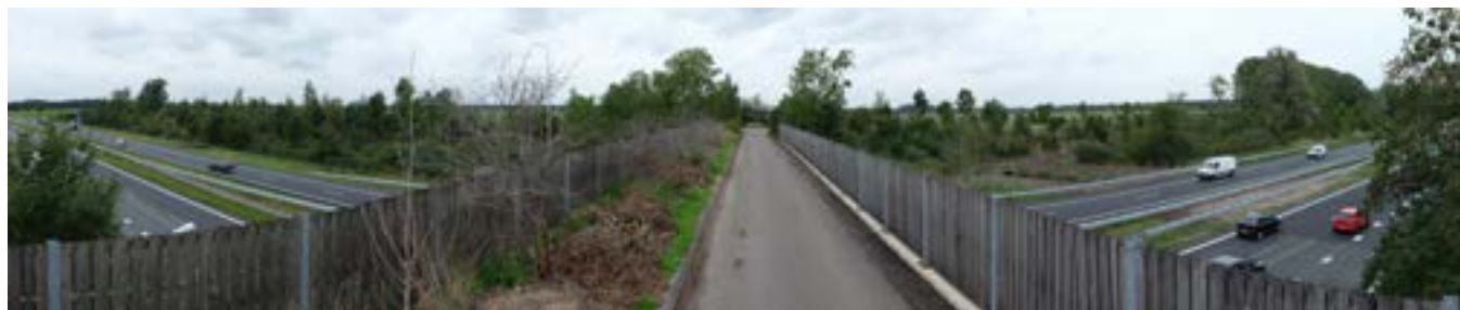
Groenstrook op viaduct voor medegebruik door fauna
