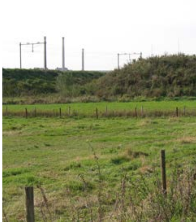
Om te voorkomen dat dassen hun burcht in het talud van het spoor maken, is in de directe omgeving een terp aangelegd met een kunstburcht. (Bron: ProRail)
