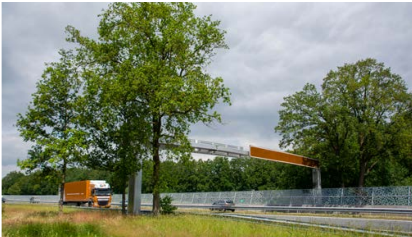
Hier is langs een bestaand portaal een lang bord (bruin) geplaatst. Op de andere helft van het portaal fungeren de signaalborden als geleiding voor de vleermuizen (Bron: Jasja Dekker Dierecologie)
