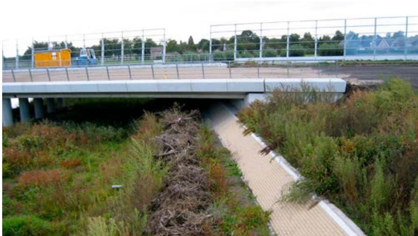
Nieuwe stobbenwal onder het spoor (bron: ProRail)
