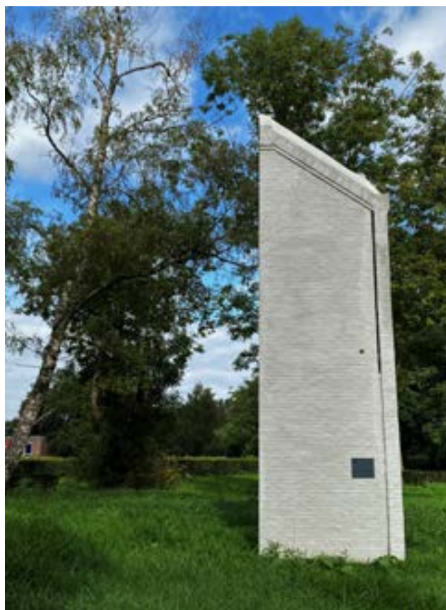
Een vleermuistoren als kunstmatige verblijfplek voor vleermuizen (Bron: Gerard Smit, Bureau Waardenburg)
