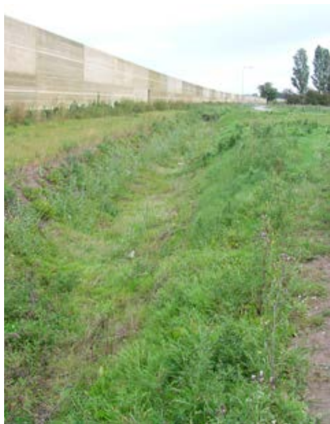
Geluidsscherm langs de Betuweroute (spoorlijn)
