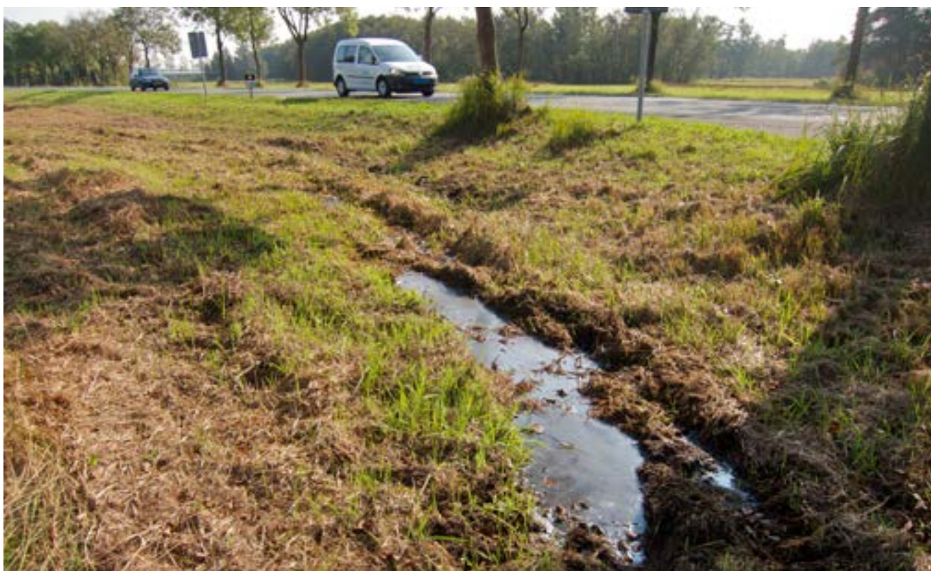
Insporing ontstaan tijdens werkzaamheden in de berm (Bron: Jan Dirk Buizer, Bureau Waardenburg)
