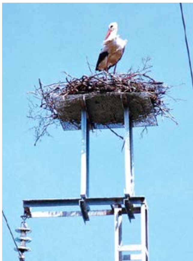
Platform voor ooievaar op elektriciteitsmast
