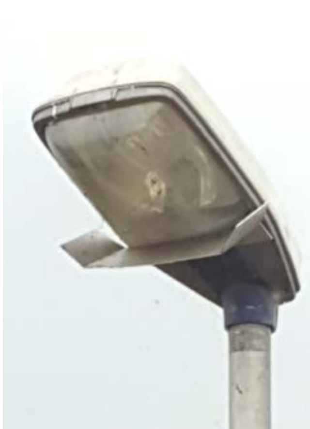
Tijdelijke verlichting bij (weg)werkzaamheden kan relatief eenvoudig worden aangepast om verstrooiing naar de omgeving te minimaliseren. In de afbeelding met behulp van een kapje
