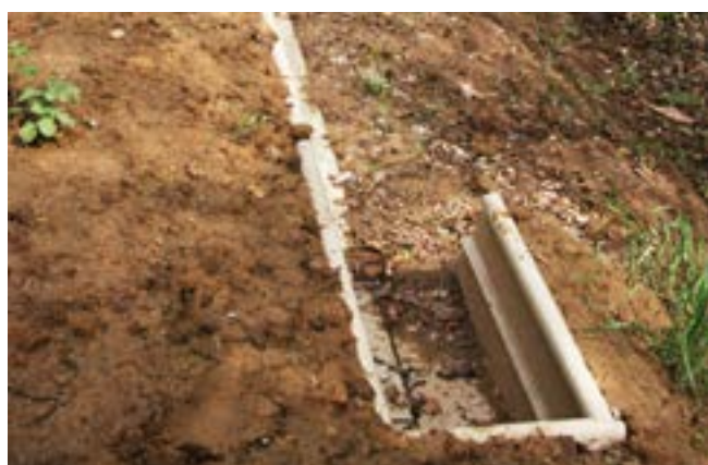
Aan het einde van stalen geleidewanden worden vaak U-vormige constructies toegepast (Bron: ACO)
