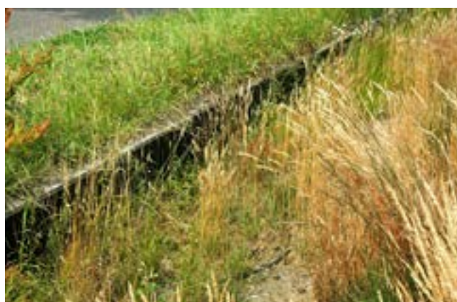
Vegetatie mag niet tegen of over het scherm groeien, want dan kunnen de dieren via de planten over het scherm klimmen
