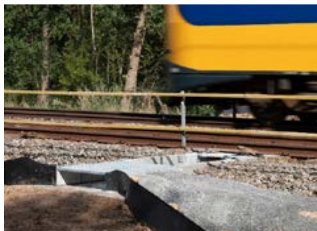
Toeloopt en ingang van een dwarsligger faunapassage (Bron: Movares)
