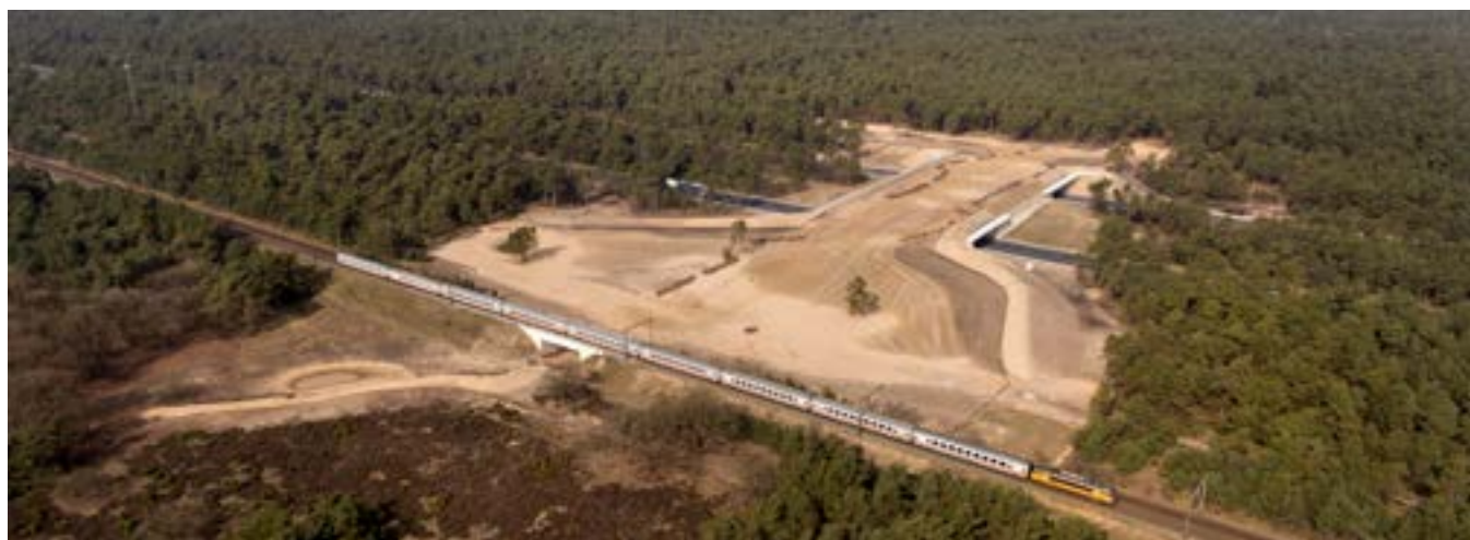
Bij Kootwijk heeft de spoorlijn naast het ecoduct een grote faunatunnel gekregen zodat dieren na het oversteken van de weg zich niet alsnog doodlopen op de spoorlijn (Bron: ProRail)
