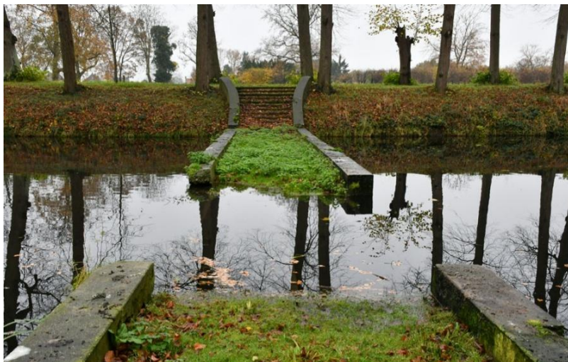
Figuur 4.23: Huidige betonnen verbinding over buitengracht
