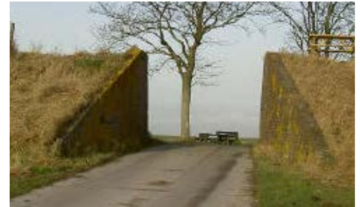
Figuur 76. Referentiefoto van een coupure met wangen van metselwerk, meelopend met de taludhellingen.
