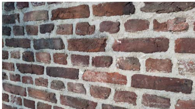
Figuur 82. Referentiefoto: Teen, voeg en verband van nieuwe muur Kasteellaan conform muur tiendschuur.
