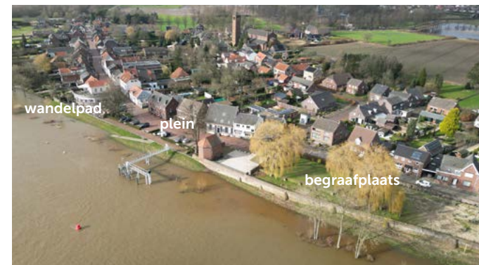
Figuur 190. Luchtfoto bestaande situatie Oud Well aan de Maas.
