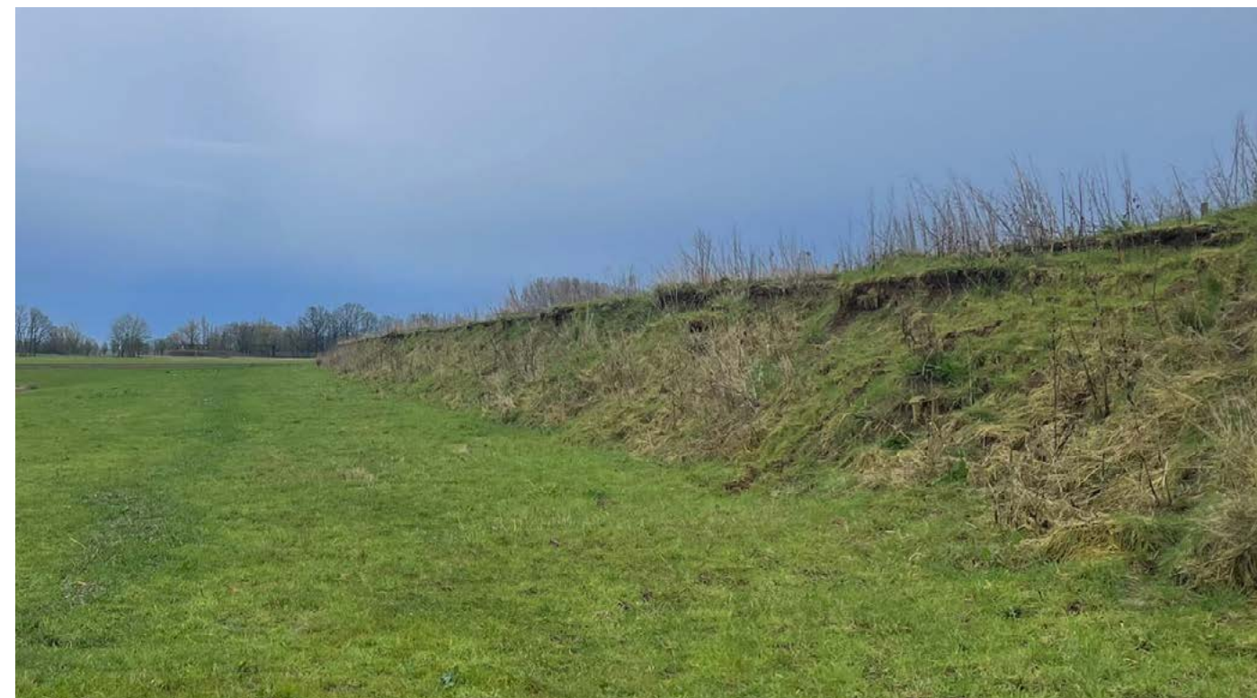
Figuur 72. Referentiefoto: Erosie buitentalud steilranddijk Ooijen Wanssum; bron: Waterschap Limburg
