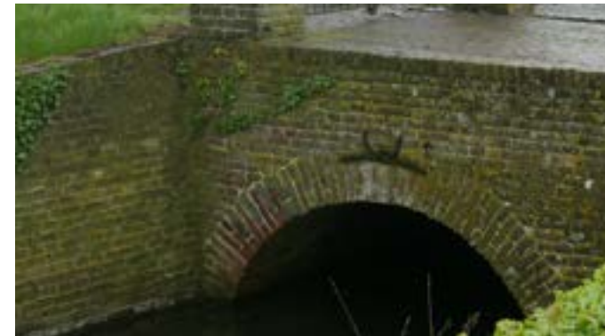
Figuur 105. Foto van historische duiker onder de brug naar de moesgaarde, als voorbeeld voor materialisatie en detaillering van de in- en uitstroombak.
