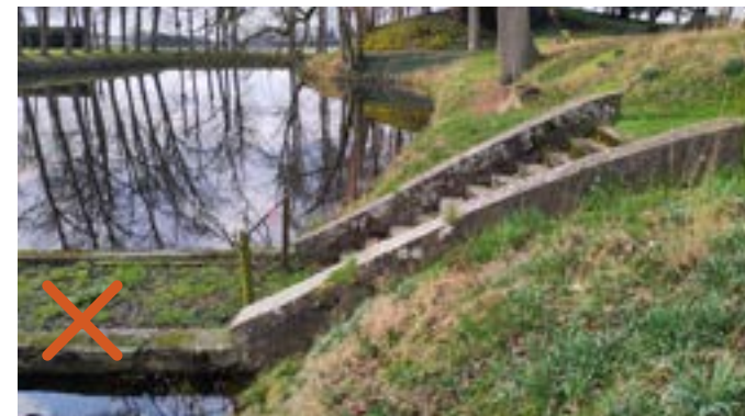
Figuur 182. Foto bestaande betonnen trap.
