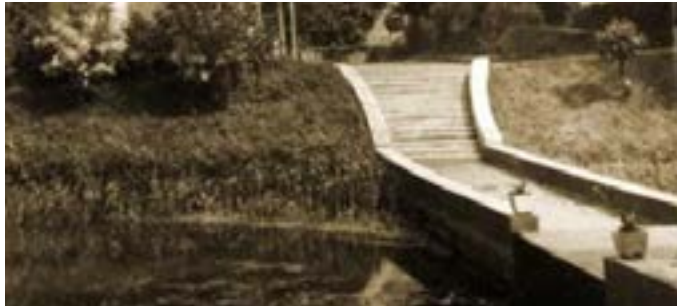
Figuur 26. Foto van de betonbrug in 1918; bron: archiefwell.nl
