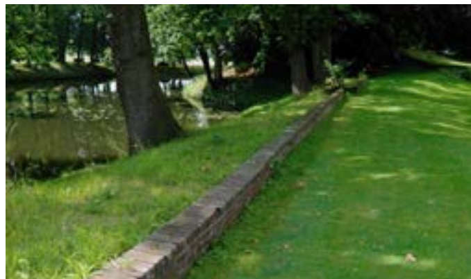
Figuur 58. Foto van een te verwijderen muurtje op de kasteelwal aan de zuidwestzijde.
