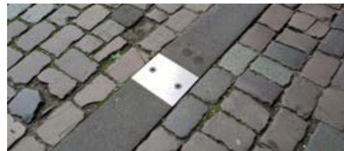
Figuur 74. Referentiefoto: De Koornmarktspoort in Kampen is een goed voorbeeld van de onopvallende bevestiging ten behoeve van de flexibele kering op het maaiveld: geen opvallende stalen strip maar overwegend van steen in een kleur aansluitend op de bestrating.
