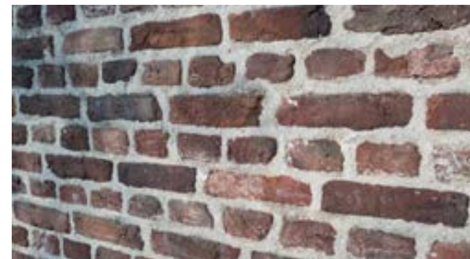
Figuur 69. Foto: Kleur en type baksteen, voeg en verband in nieuwe lage muur coupure conform gevel tiendschuur.
