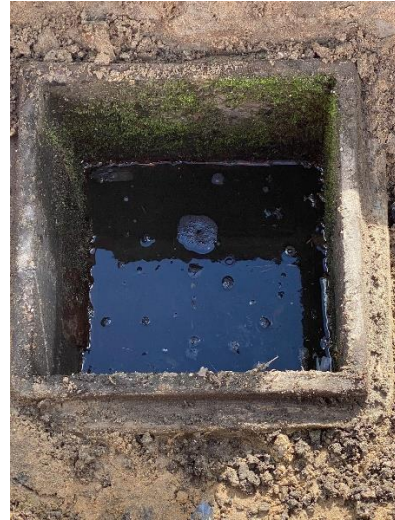
Aangeleverde foto - Tussen de kolken geen kit aangetroffen dus niet onderzocht
