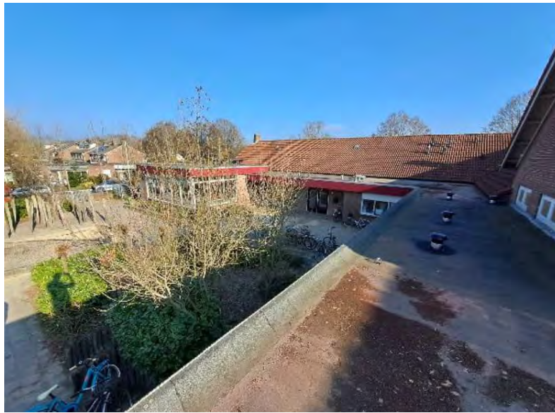
achtergevel met plat dak
